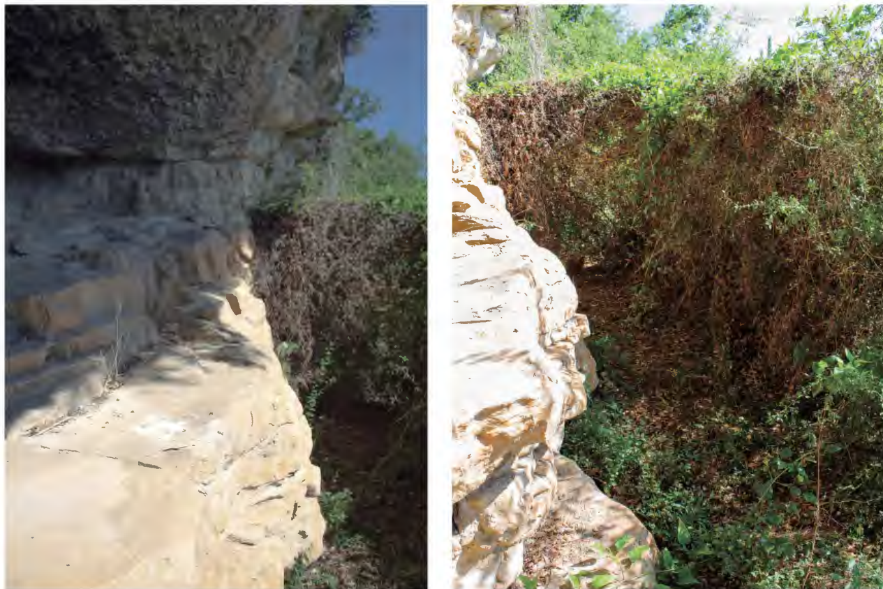
Anexo 9 a y b. Crecimiento de planta superior, enredaderas, zarzas, etc., en mayo y julio 2019 respectivamente. Appendix 9 a & b. Top-floor growth, vines, brambles, etc., in May and July 2019 respectively.
