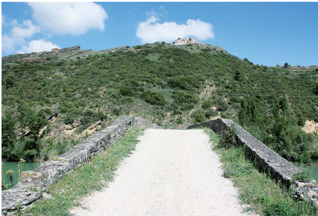
Fig. 44. Control visual de Gallipienzo sobre el puente. 📷 J. Agirre.
