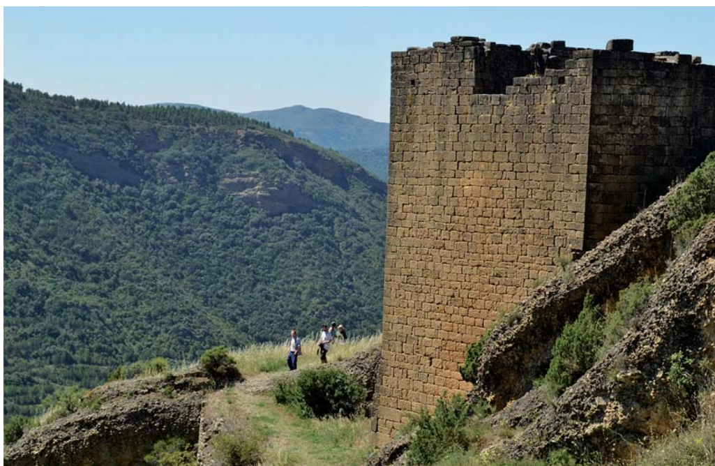
Fig. 28. Muros de la ermita de N.Sra. de la Peña.
