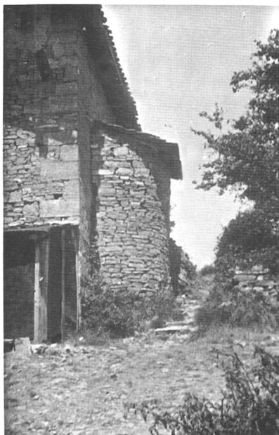
Fig. 3.—Este horno apoyado en un estribo de planta circular se encuentra en la localidad de Beramendi.
