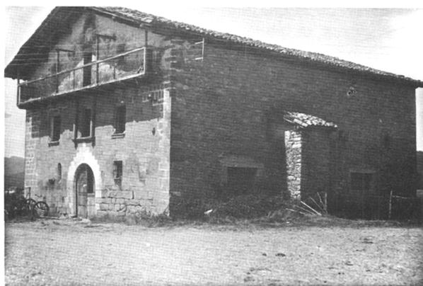
Fig. 4.—Juarbe. La construcción del horno se hace en este caso sobre un estribo de planta cuadrada.
