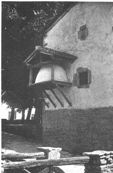
Fig. 1.—Horno suspendido de Sorauren. Está colocado sobre cuatro tornapuntas y tiene tejado a dos vertientes. Es, posiblemente, el ejemplar mejor conservado de toda la zona comentada.
