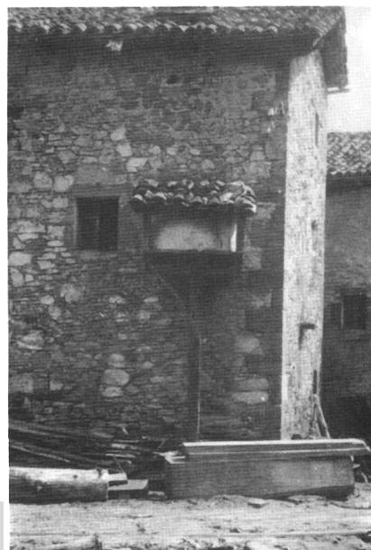
Fig. 8.—Horno de Labayen apoyado en un pie derecho rematado en forma de tridente.
