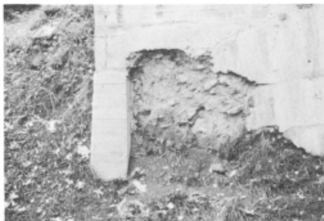
Foto 1. Depósito n.º 2 ZULUETA. Acumulación en «vrac» de origen fluvial.
