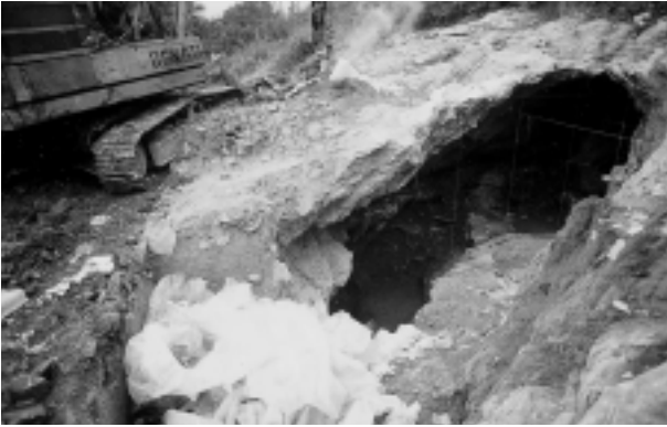
Foto 47.- Trabajo de las palas excavadoras durante la destrucción de la cavidad.
