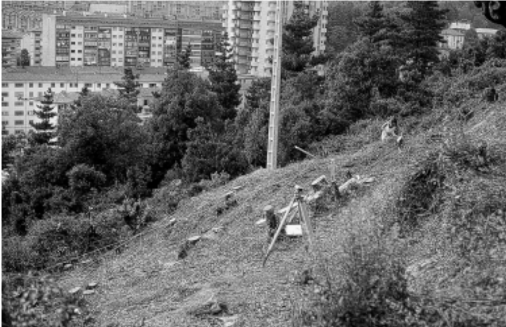
Foto 4.- Tareas de topografía, previas al desmonte de la ladera.
