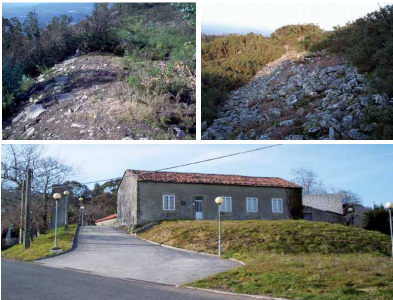
Fig 6. Arriba, detalle del estado actual de las murallas altomedievales de Castro da Hermita de San Marcos y Castromaioir, respectivamente. Abajo, estado actual de la mota de Lamascal, enrasada en los años 70 para construir la casa parroquial, y el campo y palco para las fiestas parroquiales, no visibles en la fotografía.
