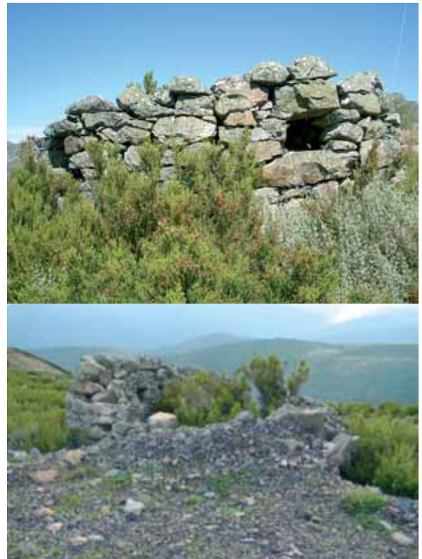
Fig 3-4. Nidos de ametralladora en la zona de los parapetos, posiblemente construidos a toda prisa dada su escaso empaque, con material reutilizado de antiguos corrales o chozas de pastor cercanos. El control visual desde este emplazamiento resulta espectacular y alcanza tanto al valle como a los cordales situados inmediatamente a este y oeste.
