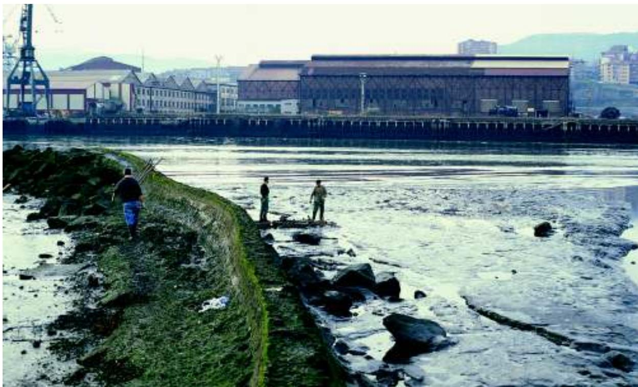
Figura 3-13: Detalle de la perforación en la zona de desembocadura del Gobelás. El sondeo de percusión PCGb se realizó a la derecha del dique.
