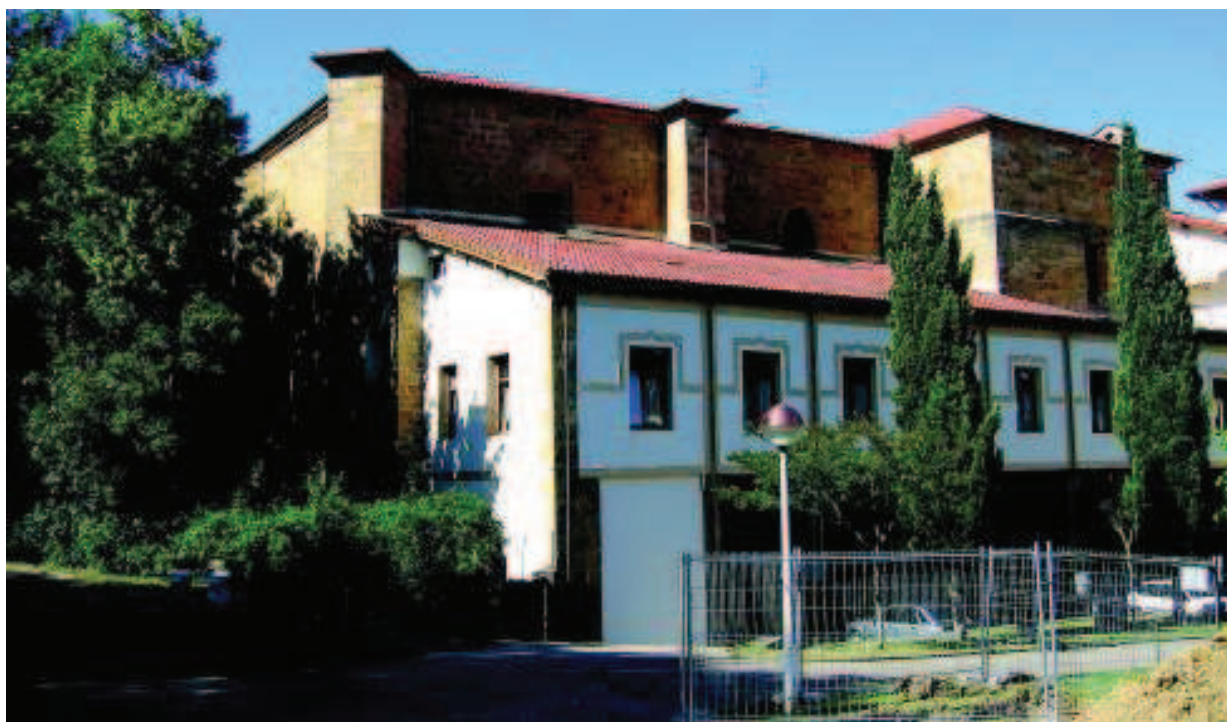
Fig. 7. Nave renacentista de Santa María de Zarautz, con las ampliaciones modernas del pórtico y las dependencias parroquiales.
