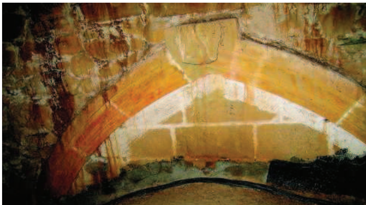
Fig. 8. Antiguo formateo de la bóveda renacentista de Zarautz, oculto entre las nuevas bóvedas barrocas y el bajocubierta de la iglesia.
