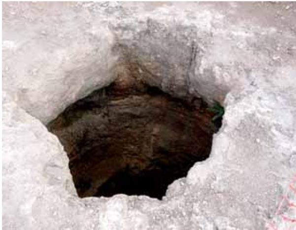
Fig. 12. Boca del pozo que en la Zona 1 de Aberturas explotaba el Acuífero 23 (UC 11). En la imagen se aprecia el desgaste de la roca en varios puntos.
