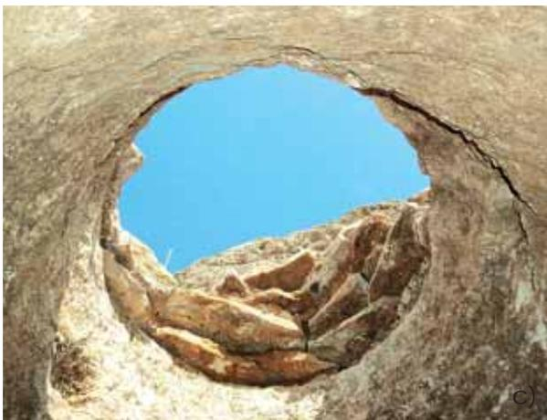
Figs. 18a, 18b y 18c. Vistas cenital, frontal e inferior del cierre de uno de los silos, mediante lajas de caliza dispuestas por aproximación de hiladas, trabadas con argamasa de cal y barro. El silo ha permanecido vacío hasta nuestros días.
