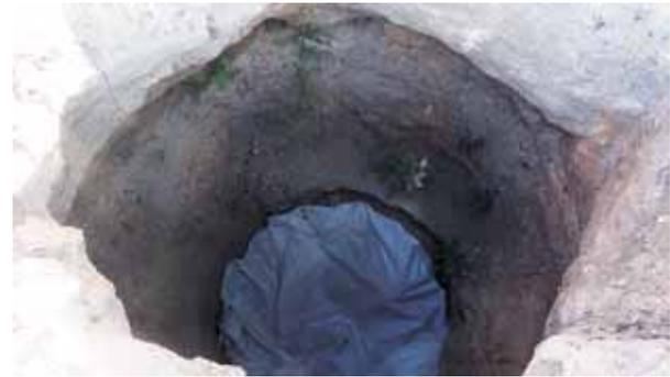
Fig. 13. Pozo de la Zona 1 de Aberturas (UC 11). A 80 cms. por debajo de su boca se aprecian unos mechinales destinados a sustentar una plataforma de madera.
