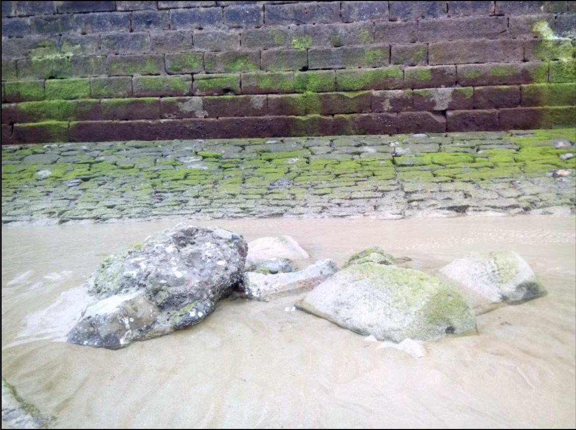
Figura 50. Detalle de los bloques de la escollera.
