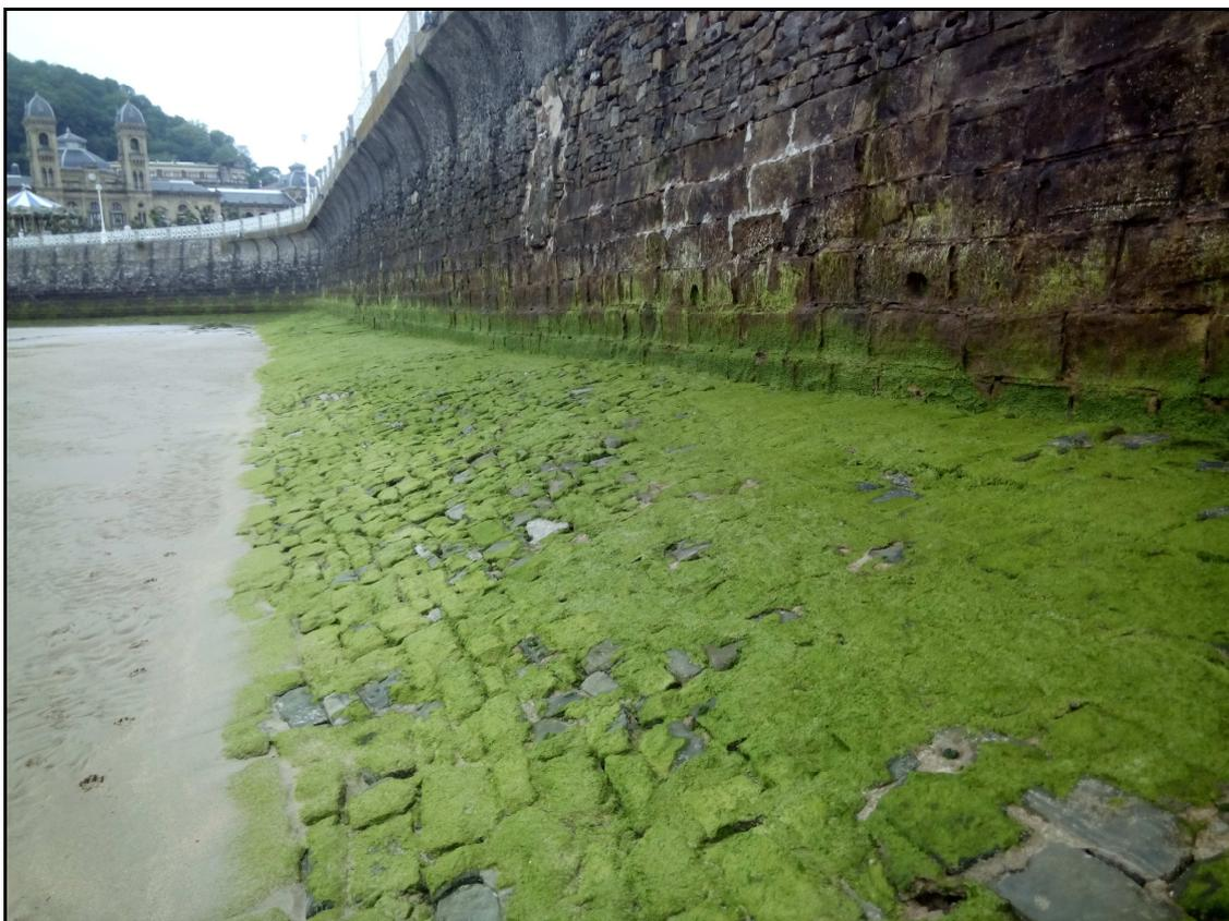
Figura 16. Zapata de mampostería a pie de muro en Alderdi-Eder.
