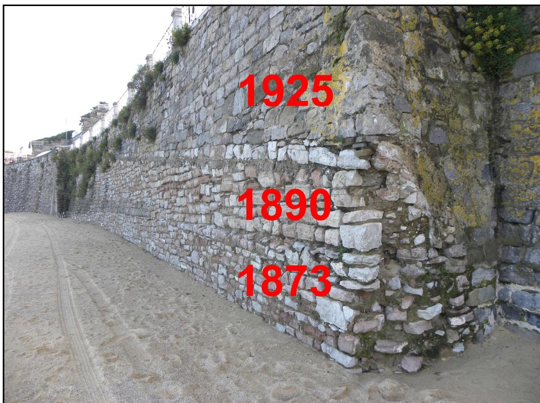
Figura 3. Muro de costa del antiguo campo de maniobras (1873), levante del muro tras construcción del túnel del Antiguo (1890) y construcción del muro de los jardines de Ondarreta (1925).
