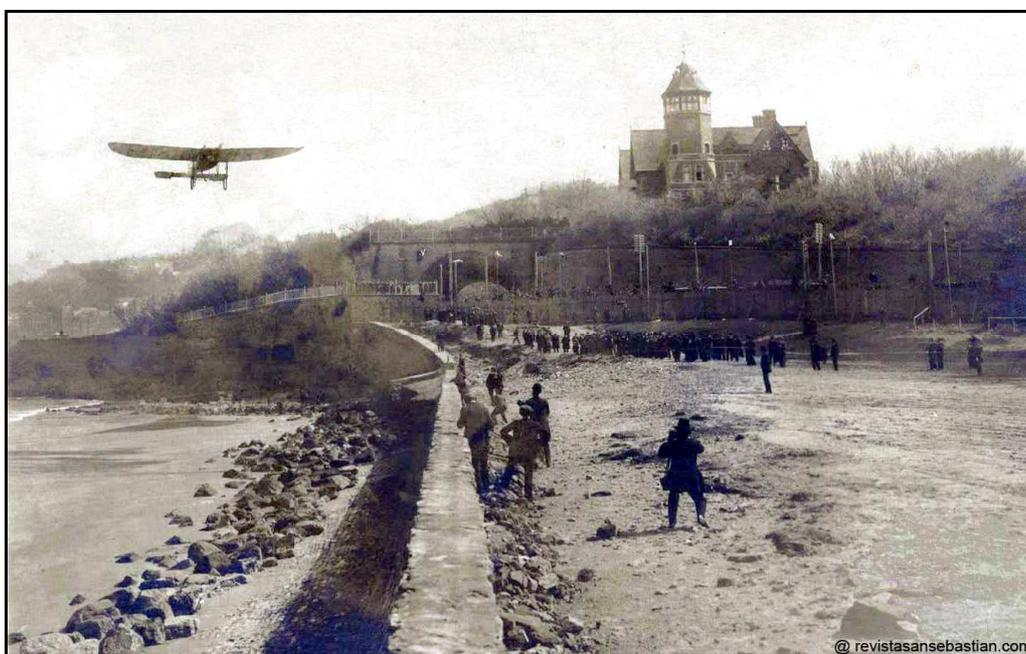
Figura 7. Vista con la zapata a pie de muro y la escollera paralela. Fecha: 1910.
