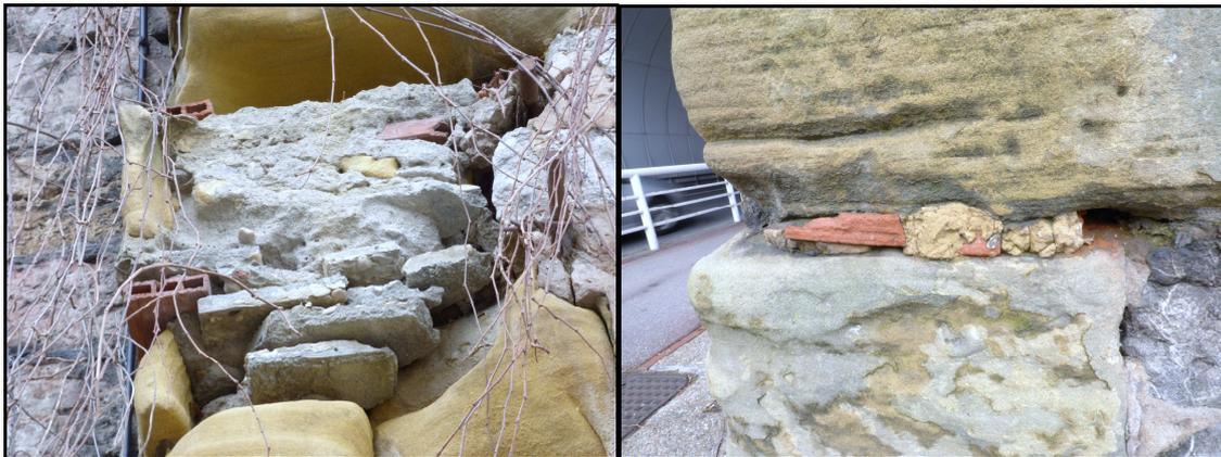
Figura 15. Reparaciones en las cantoneras de sillería del Tunel de Antiguo.
