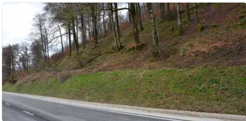
Fig. 66. La plataforma de la calzada seccionada longitudinalmente por la carretera.
