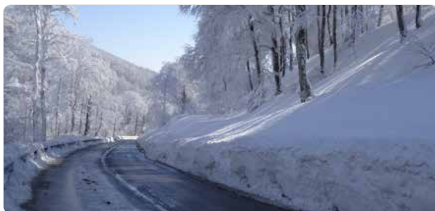
Fig. 67. Plataforma ascendiendo Ibañeta por encima de la carretera.
