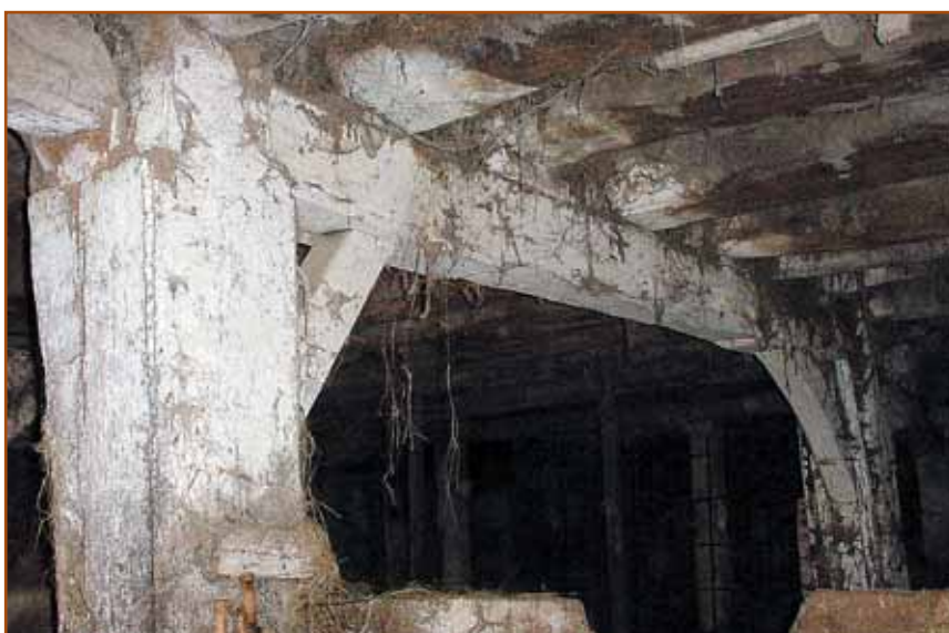
Lehen solairua eusten duen egitura ukuilutik ikusita
