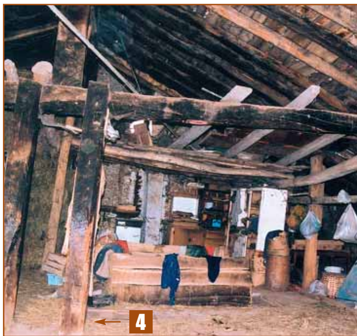
4- Telaituraino doazen dolarearen berniak 5- Berniaren xehetasuna erregulazio-zuloekin 6- Gailurreko habea
