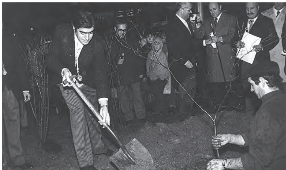
Pedro Recalde Busca –Samaniego ikastetxeko lanen inaugurazioa / Pedro Recalde Busca - Inauguración de las obras del colegio Samaniego. (TUA / AMT)
