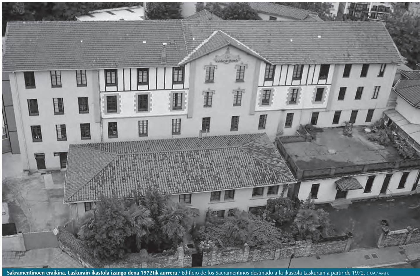
Sakramentínoen eraikina, Laskurain ikastola izango dena 1972tik aurrera / Edificio de los Sacramentinos destinado a la ikastola Laskurain a partir de 1972. (TUA / AMT).
