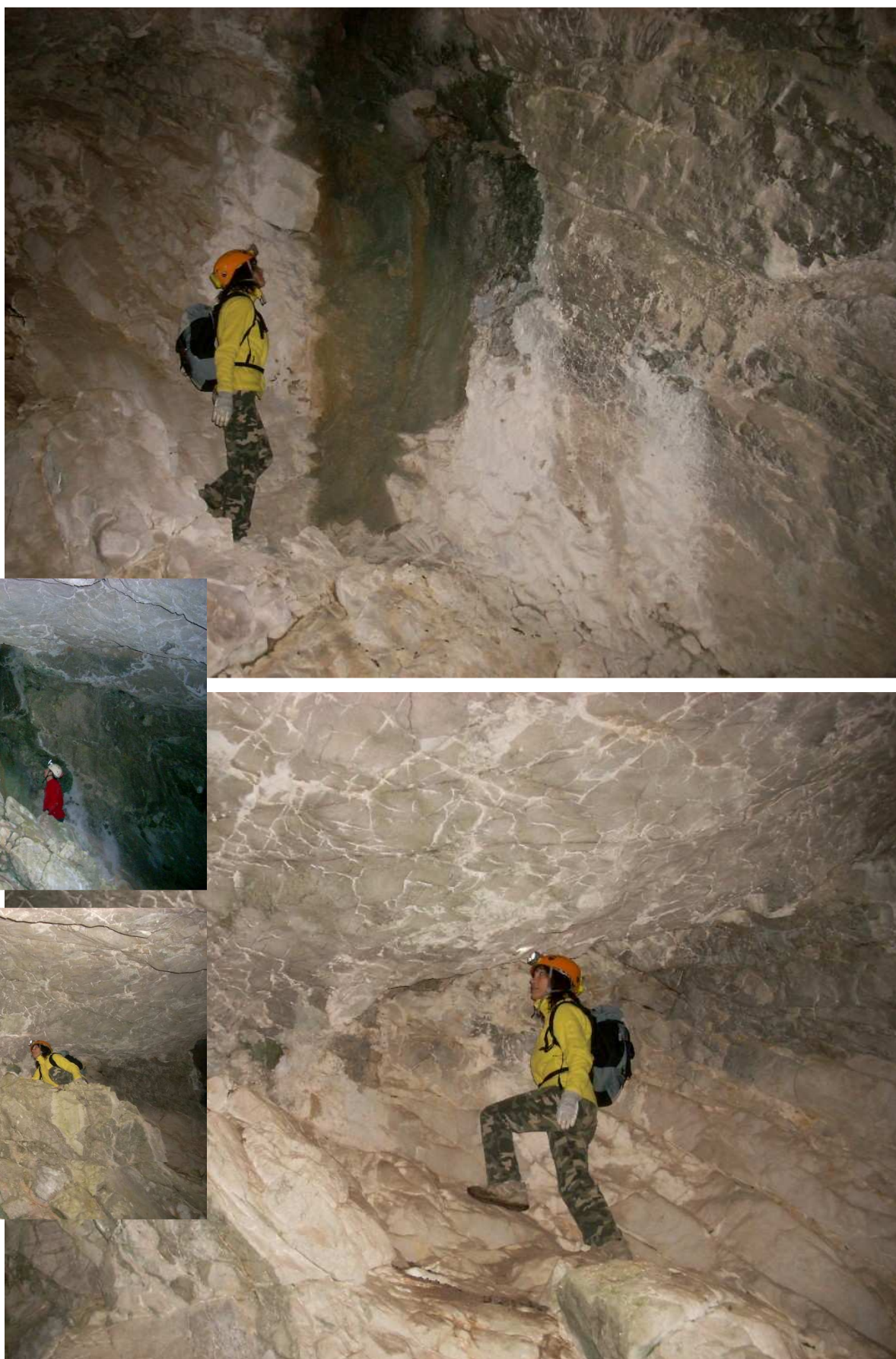
Figura 18. Cueva de Aldaola 10. Detalles de cornisas, filtraciones y nichos sobre la pared izquierda.
