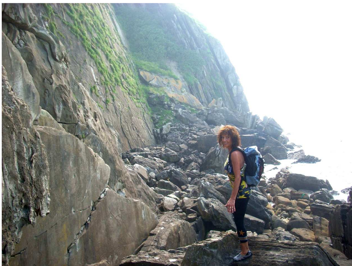
Figura 2. Sendero de acceso desde la carretera del faro de Igueldo y explanada inferior, con la pared Norte del faro y la punta que prosigue hacia el sector de Mako. Nótese los estratos subverticales y zonas de colapso.
