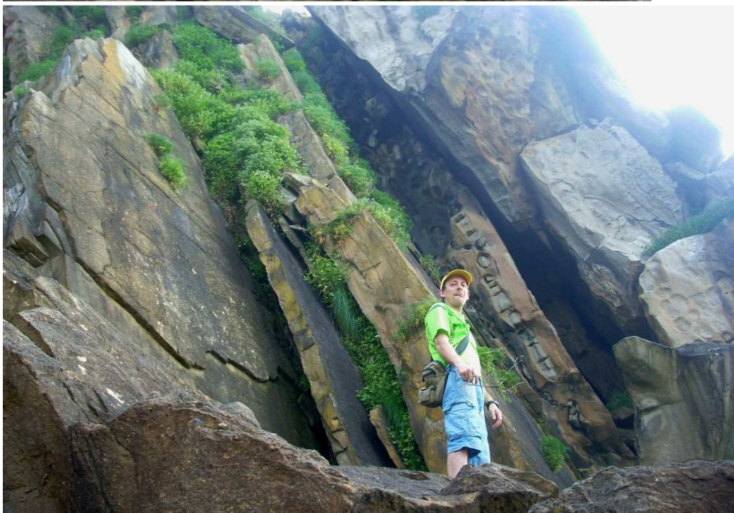
Figura 7. Punta al W de la pared N del faro, con indentaciones inter-estratos y bloques en proceso de colapso.
