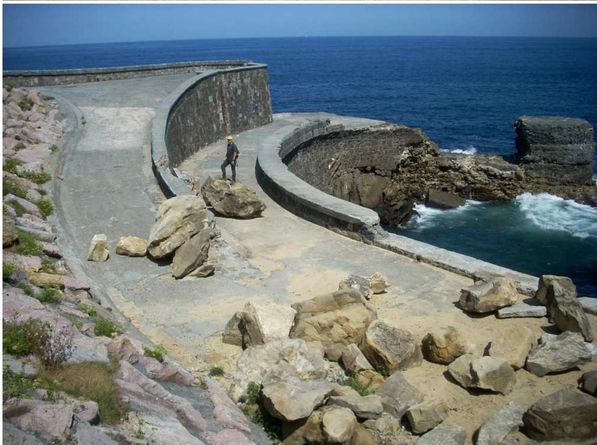
**Figura 3.** Bloques desprendidos de los escarpes superiores que han destruido parcialmente la estructura que protege la salida del colector de Tximistari. Muchos otros bloques han caído al mar. Los desprendimientos son recientes.
