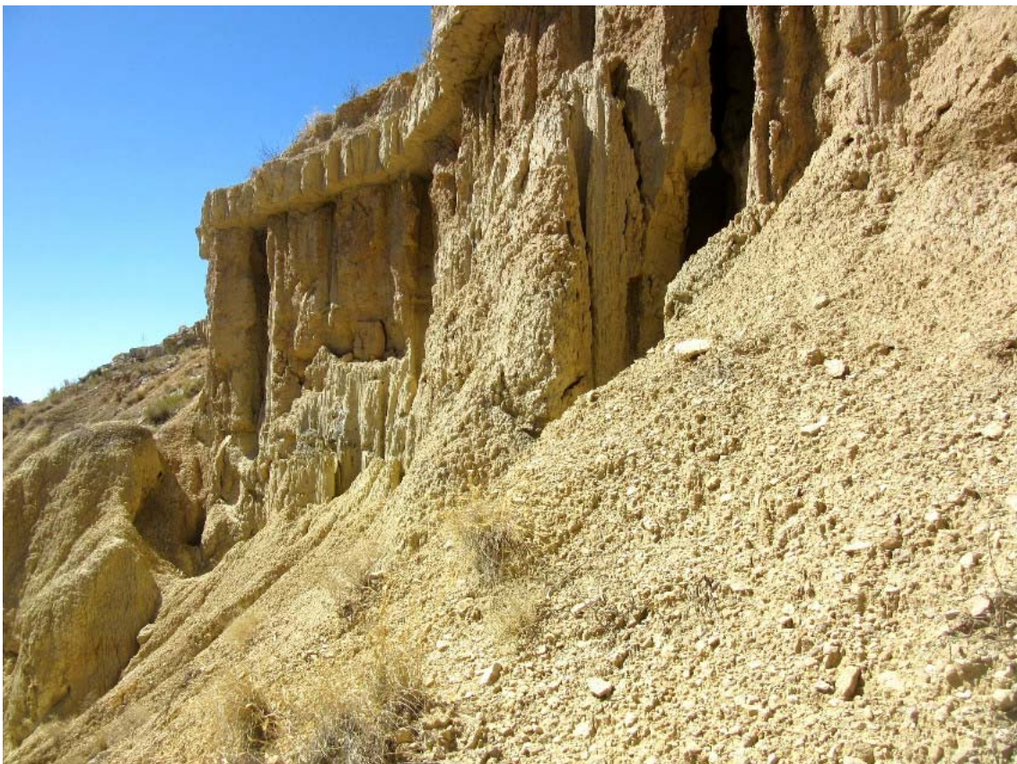
Figura 23. Escarpe vertical bajo estrato resistente de caliza, con dos cuevas con galerías internas habitadas por quirópteros. En el talud, diversas geoformas de superficie, con conductos de piping. Sistema La Nasa 05.
