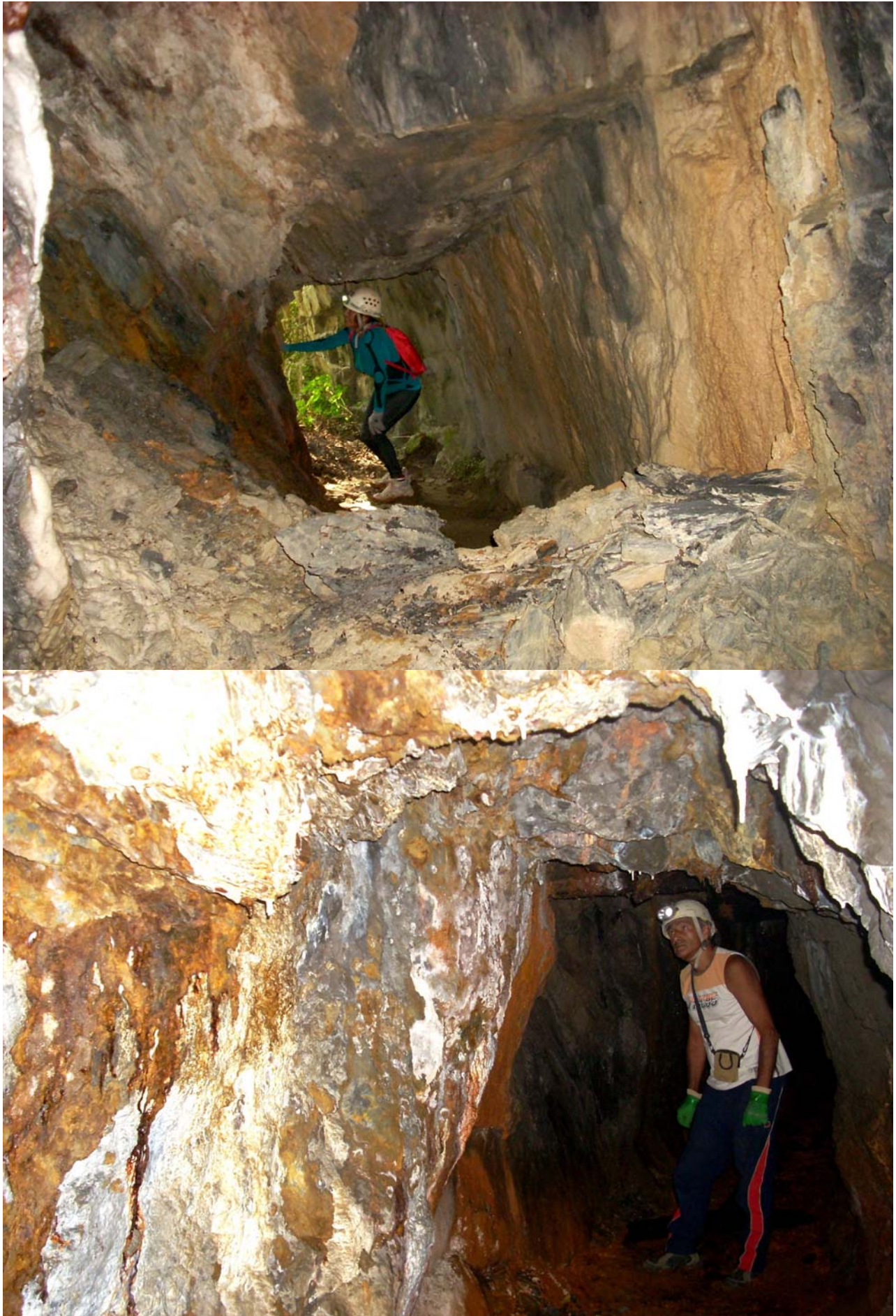
Figura 4. Minas de Burusburu. Boca de acceso de Burusburu 1. Un pequeño derrumbe produce una ampliación, y entre ésta y la boca se forma en época de lluvias una laguna de poco fondo. Las imágenes son de época seca (arriba). Tramo inicial con espeleotemas de calcita y oxi-hidróxidos de hierro (limonita y goethita) (debajo). Nótese algunos restos de madera del entibado en el techo.
