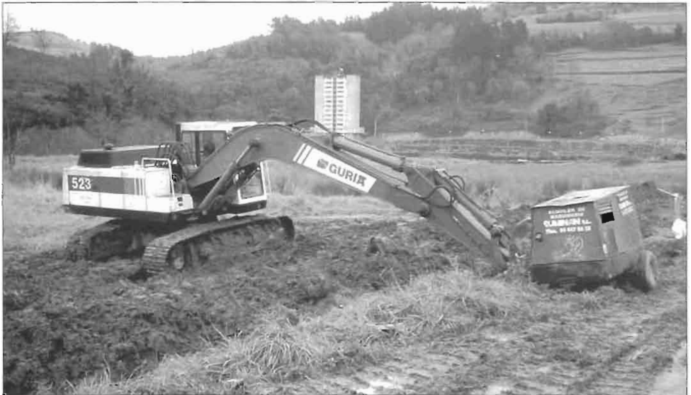
Acometida de la instalación de gas natural (27-01-2001).
