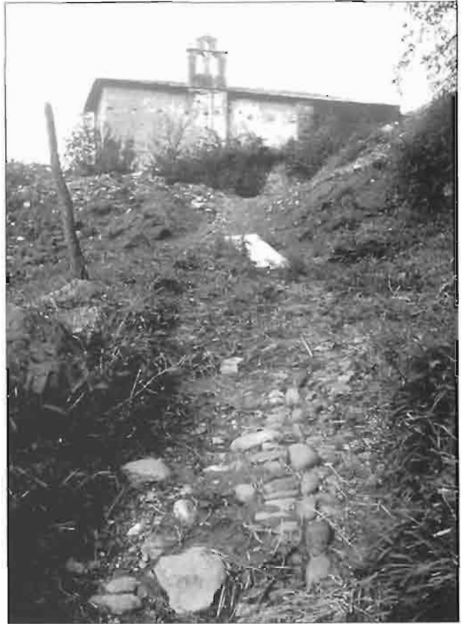
Foto de octubre de 1990, calzada de canto rodado con espina central.
