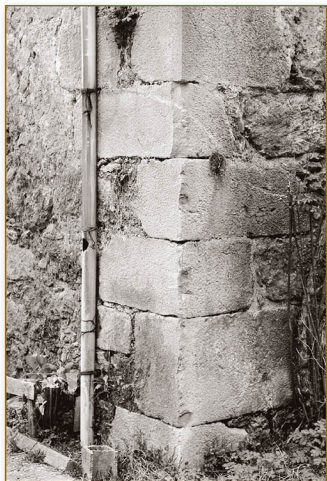
Detalle de esquinela de piedra sillar en el ángulo de la fachada principal y su derecha en la casa torre de Leizaola. Marzo 2010.
