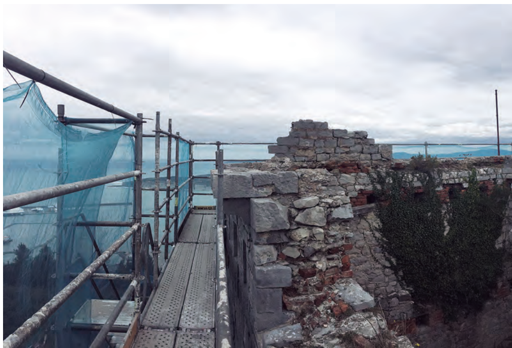
Barruko ikuspegia, lanak hasi aurretik. / Panorámica interior del torreón al inicio de la obra.
