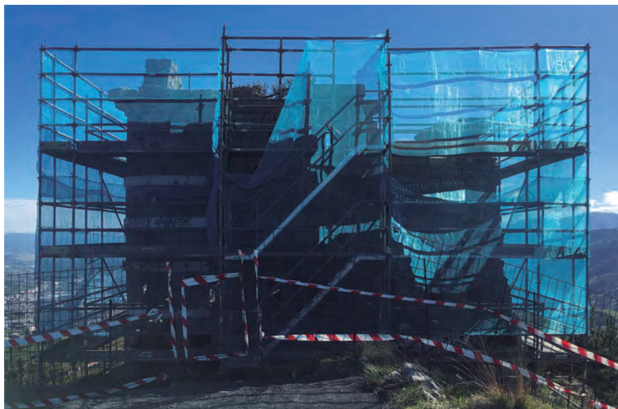
Ipar-mendebaldeko fatxada, obra hasieran. / Fachada noroeste al inicio de la obra.
