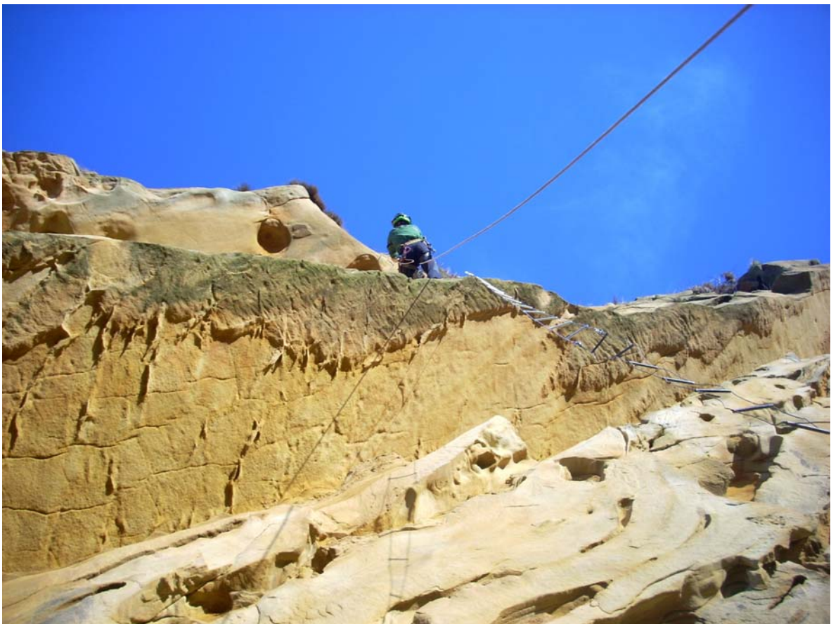
Figura 10. Los tramos aéreos de acantilados extraplomados resultan de singular atractivo estético. La arenización lateral de los estratos de roca deja en relieve positivo curiosas geoformas, residuo de la meteorización de la a menudo recementada superficie externa de la arenisca. Se puede decir que es en el interior de las cuevas y en estas superficies karstificadas donde mejor se aprecian las características litológicas primarias de las rocas del flysch.
