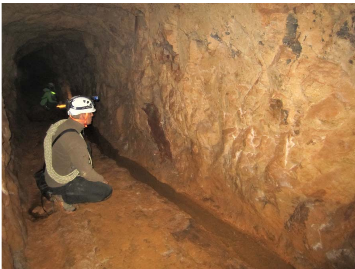
Figura 07. Parte terminal de la galería minera, de 187 m, con cauce subterráneo y algunos derrumbes laterales.
