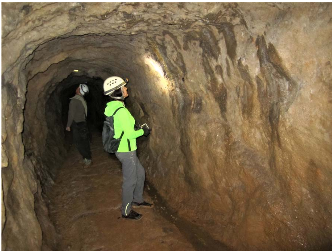
Figura 02. Galería principal de la mina-cueva de Andazárrate en su parte interna, con canal lateral de drenaje.
