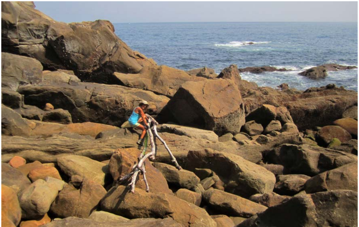
Figura 23. Estratos subverticales del extremo W del acantilado de Salto, en la punta que lo separa del de Elgorri aundi y la arista rocosa de Putakiya. Nótese la ocurrencia de procesos clásticos mecánicos, lo que propicia el colapso de bloques y tramos enteros de estratos. En la imagen inferior, restos de madera aportados por el oleaje y las mareas
