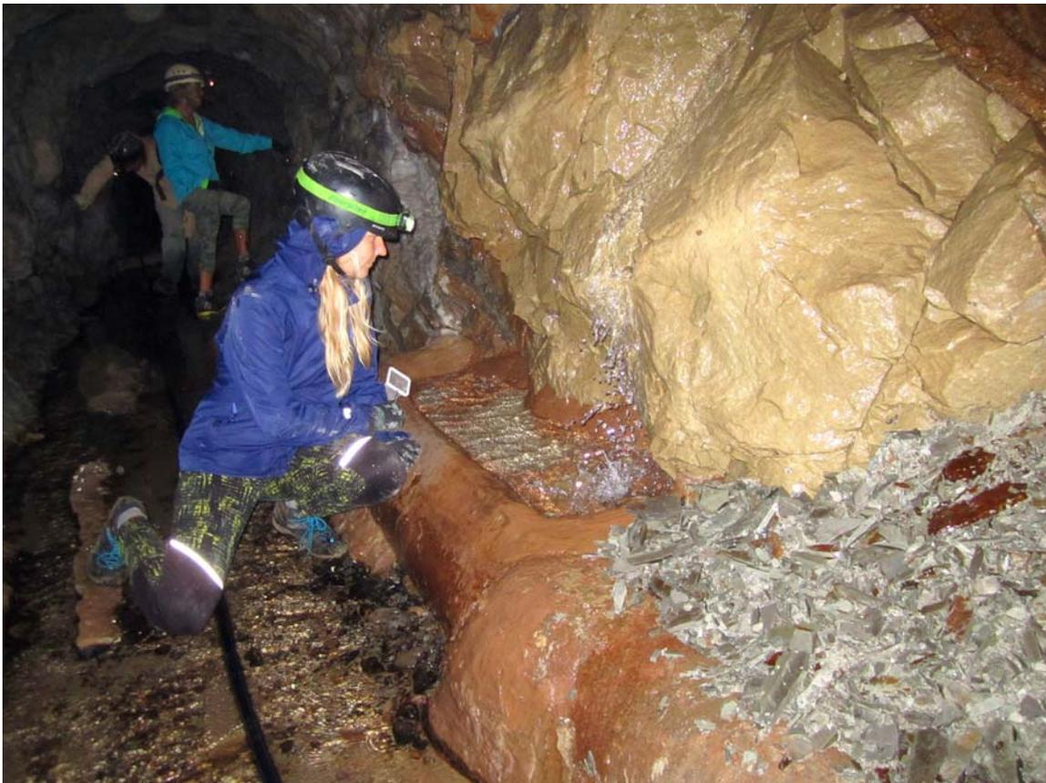
**Figura 22.** Parte central del Túnel Pasaia 01, de 1.600 m de longitud, con detalles de espeleotemas de oxi-hidróxidos de hierro y de calcita, y cubetas colectoras del agua que se infiltra en la galería al perforar acuíferos en la arenisca.
