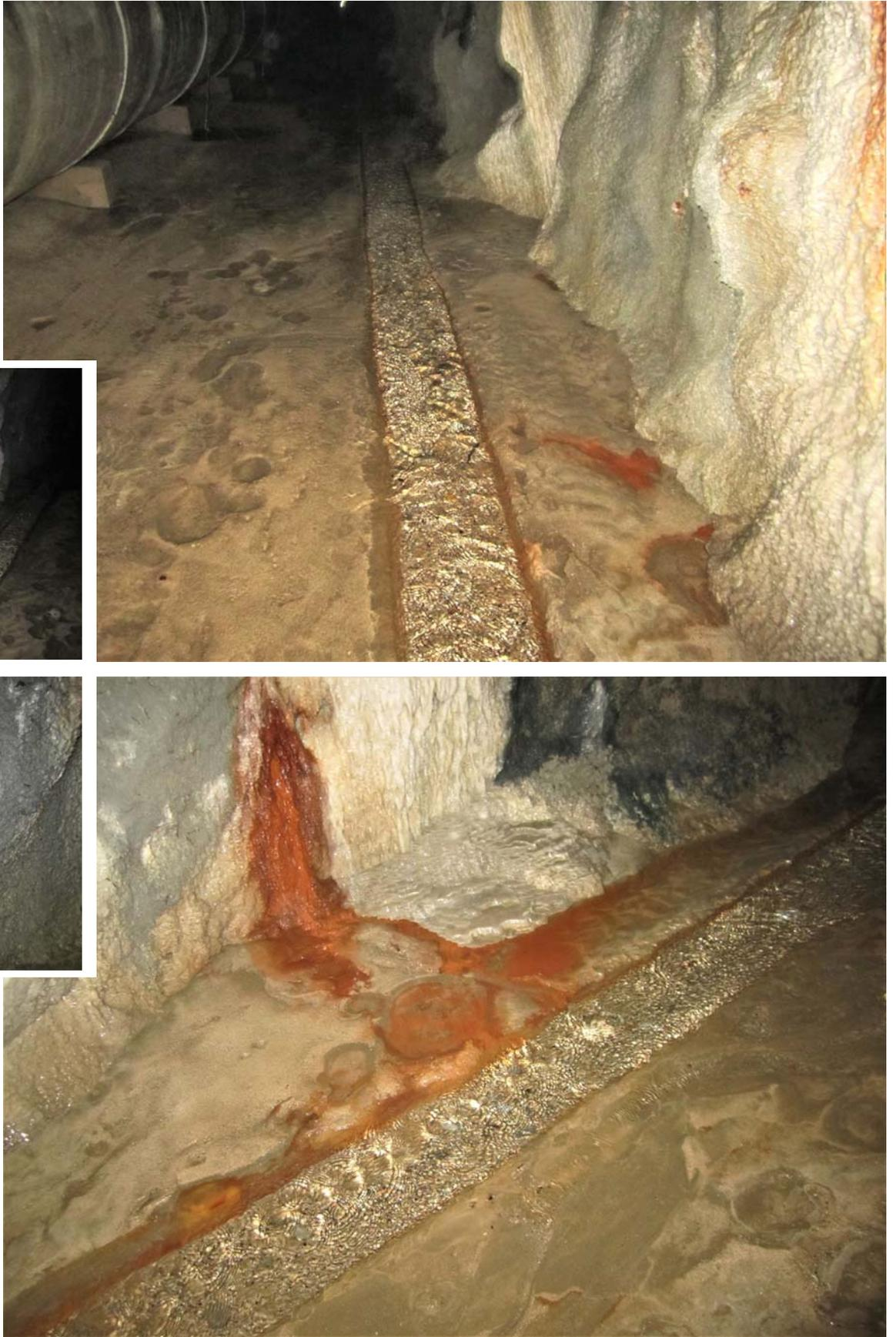
**Figura 17.** Túnel de San Pedro, con detalles del canal interno (de aguas cristalinas), depósitos de arena en el cauce y sobre las aceras laterales, y diversidad de espeleotemas (de calcita y oxi-hidróxidos de hierro).
