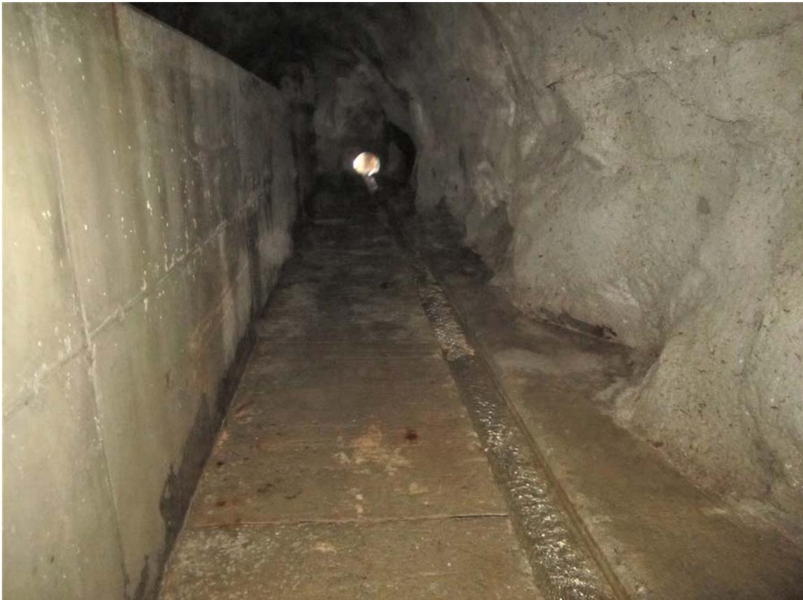
**Figura 15.** Tuberías del sistema de bombeo del emisario submarino al lado de la entrada, y primer tramo del túnel, con la tubería del emisario incluida en un encofrado de concreto y el pequeño canal al lado. El tubo de la surgencia al fondo.
