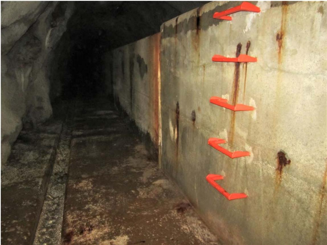
**Figura 14.** Vista del tubo que lleva el agua del canal a la surgencia en cascada (arriba) y vista hacia el interior del túnel (debajo), con el pequeño canal que recoge aguas de infiltración (en su lado N) y la gran tubería (en el lado S) recubierta en este tramo por un encofrado de concreto. El túnel tiene 5 m de diámetro.
