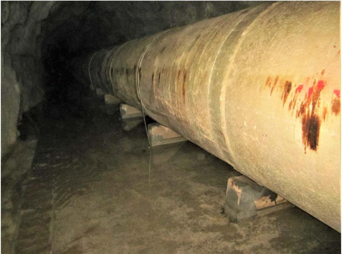
**Figura 16.** El canal y suelos de cemento con depósitos arenosos y la gran tubería del emisario (de 1,7 m de diámetro).
