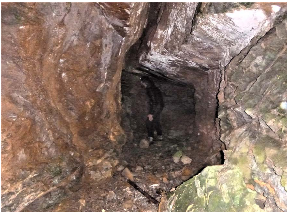
Figura 19. Mina-cueva Ezurtza 01. Detalles de la roca-caja, con fractura en el techo, y bloques deprendidos.
