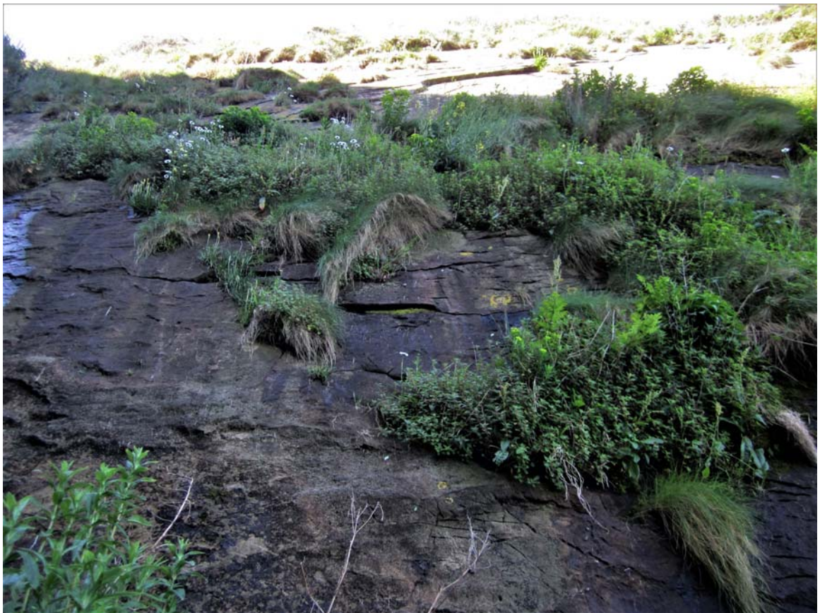
Figura 04. Vistas hacia la zona inferior de bloques y hacia la placa W de descenso, con vegetación adherida a la roca.
