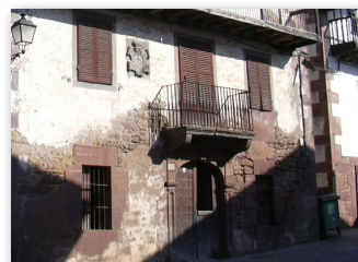
Fachada a restaurar
