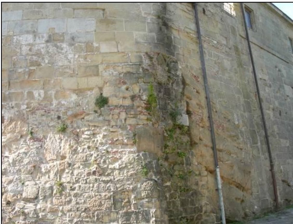
Figura 12. Restauración parcheada del Castillo de la Mota.
