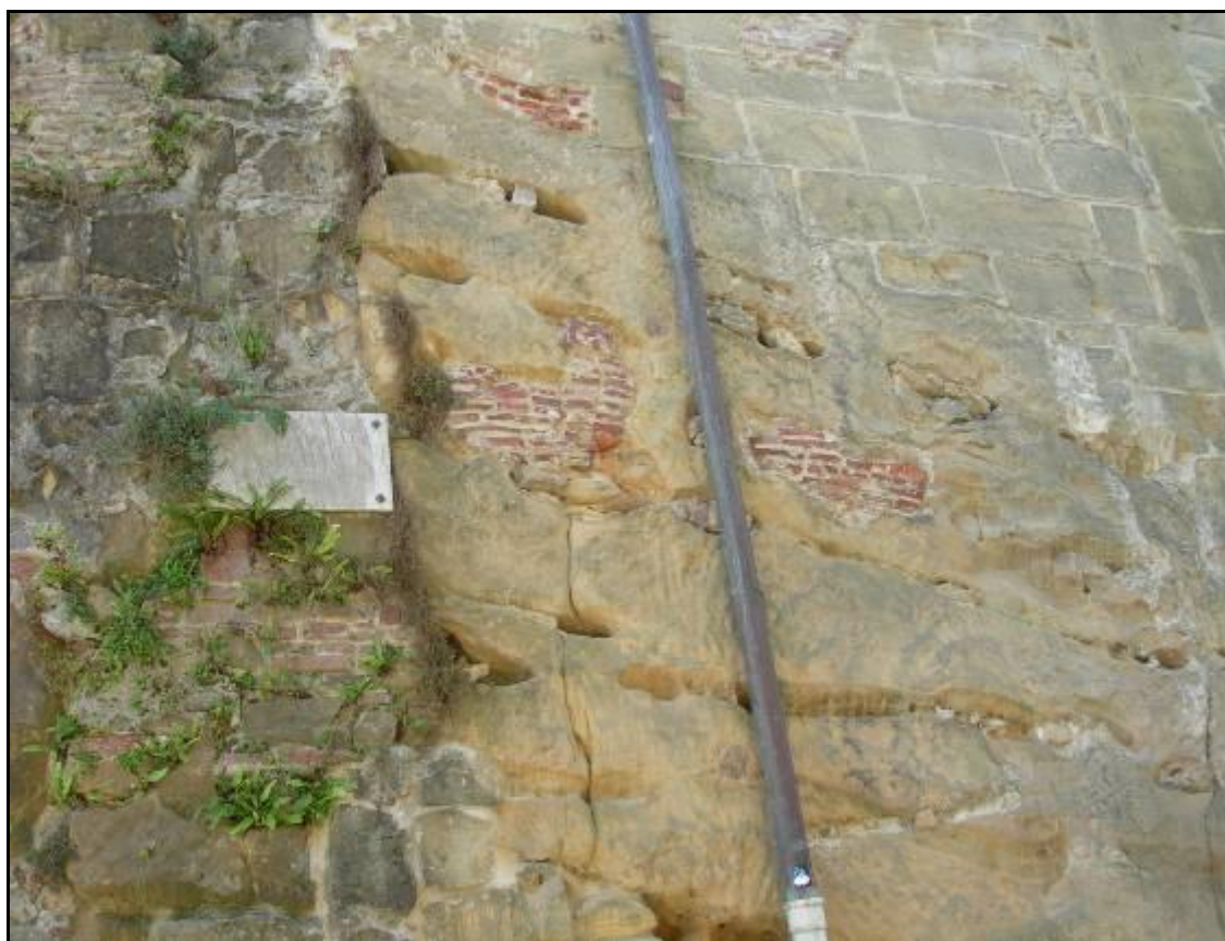
Figura 11. Reparaciones similares con ladrillos macizos en el Macho del Castillo Roquero de Urgull.
