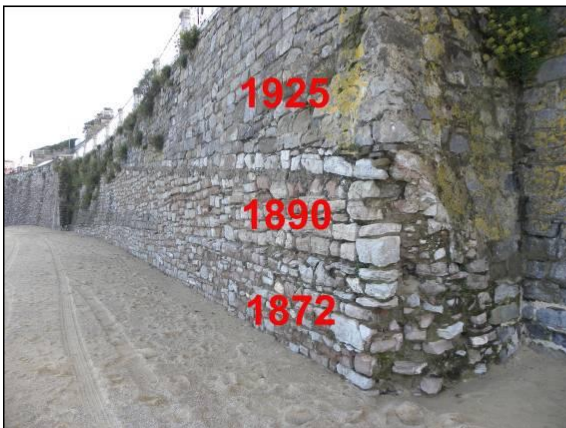
Figura 4. Muro de costa del antiguo campo de maniobras (1872), levante del muro tras construcción del túnel del Antiguo (1890) y construcción del muro de los jardines de Ondarreta (1925).
