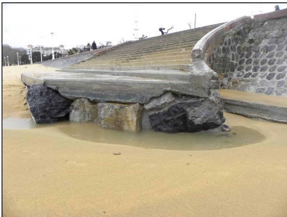
Figura 40. Cimentación de las escaleras occidentales al descubierto.
