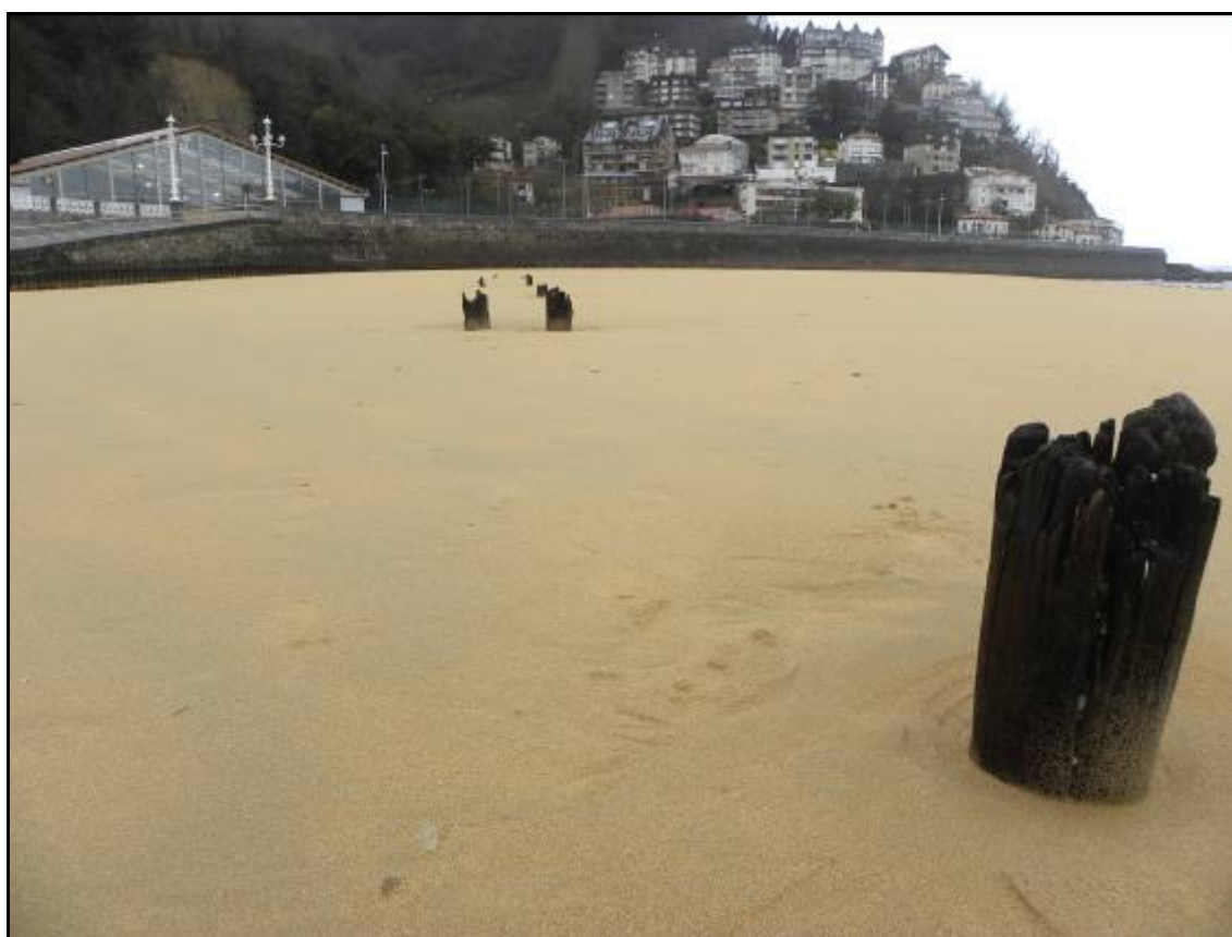
Figura 26. Grupo de pilotes occidental.
