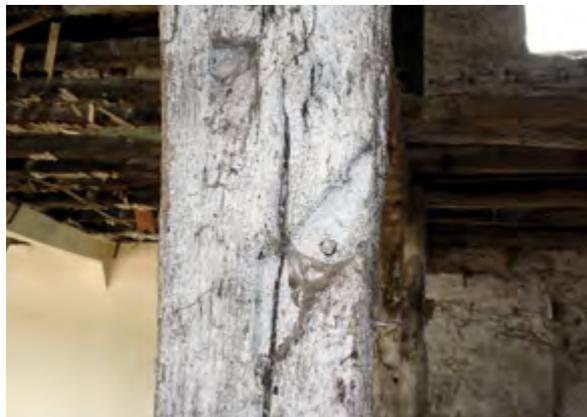
Estructura interior de madera del Caserío Lukusain Zaharra (Itsasondo) durante el proceso de desmontaje y detalle de uno de los enlaces a cara de cola de golondrina con su pasador de madera. © A. MORAZA
