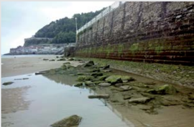
Figura 2.1. Afloramiento de escollera (09-05-2015).
