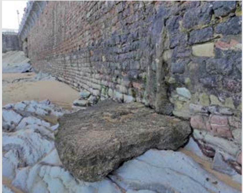
Figura 6.3. Plataforma de hormigón para ducha seca sobre los estratos (01-01-2022).
