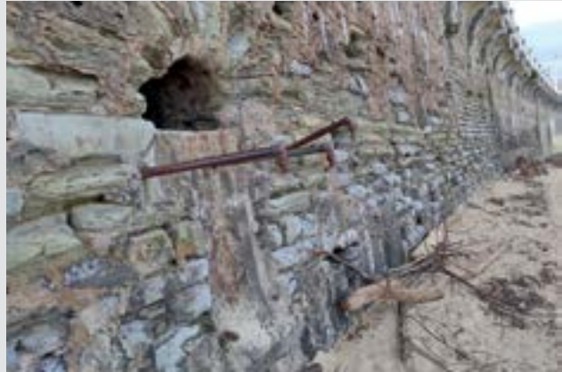
Figura 5.4. Antiguas duchas a la altura del paseo de Miraconcha 26 (26-12-2021).
