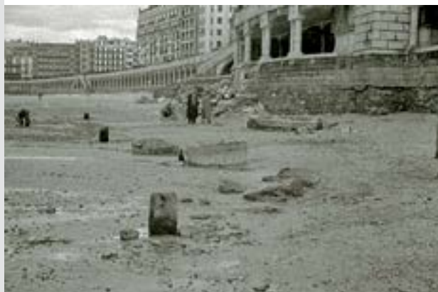
Figura 3.3. Pilotes de madera y estructuras del antiguo balneario de El Perlón (1951), desmantelado en 1906. www.kutxateka.eus
