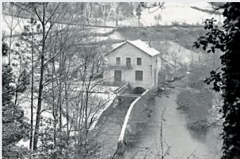
Central hidroeléctrica de Otita en la época de funcionamiento (Andoain).
