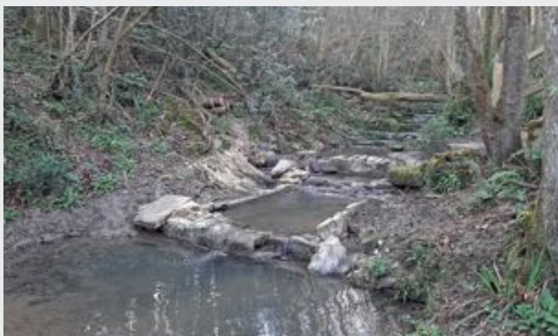
Vista del Lavadero de Pakea (Donostia) tras los trabajos de recuperación. M. GARCIA
