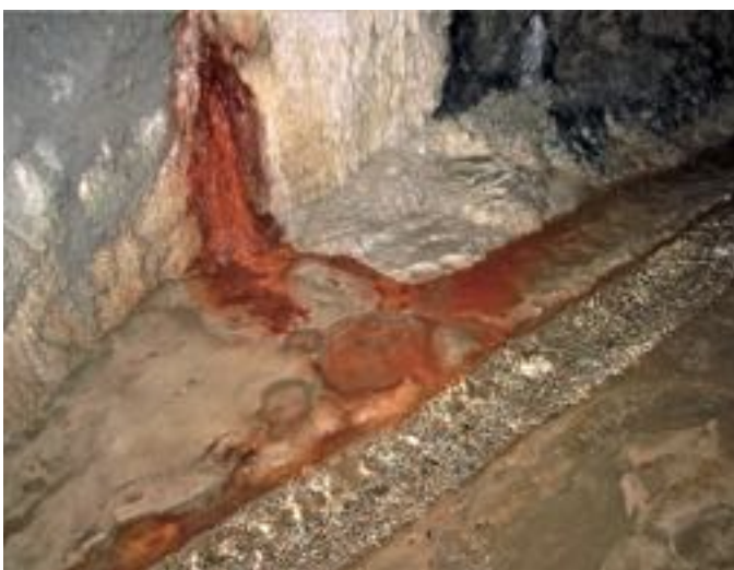
Canal, espeleotemas y rellenos arenosos en el interior del Túnel de San Pedro, de 1,5 km.
