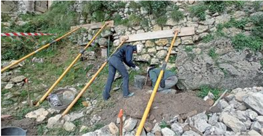
Registro del depósito arqueológico en la base del muro de cierre E durante los trabajos de recuperación y consolidación en el Túnel de San Adrian/Lizarrate.
