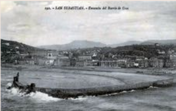
Figura 11. Construcción muro del ensanche del Kursaal. https://www.guregipuzkoa.eus
