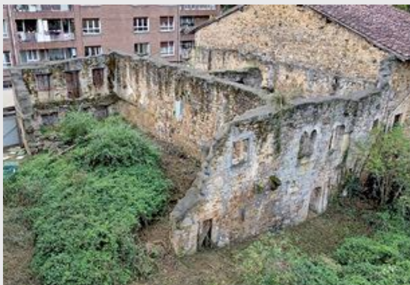
Vista aérea de la fachada trasera de los solares de San Pío X n° 50-52-54 (Elorrio). M. CEBERIO
