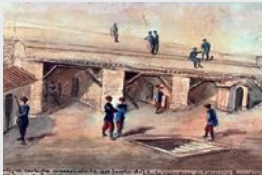
Batería acasamata del Fuerte de San Juan de Arandigoyen, con una estructura muy similar a la habilitada en el Fuerte de San Miguel de Miravalles de Uharte durante la Segunda Guerra Carlista (1875).
