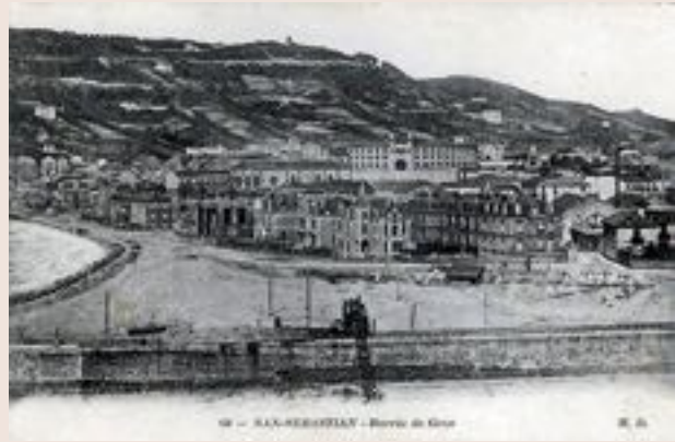
Figura 10. En construcción el muro del estuario del Urumea a la altura de c/ Ramón María Lili. https://www.guregipuzkoa.eus
