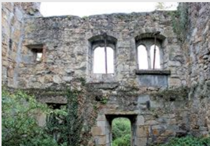
Detalle de la cara interior del muro trasero del solar de San Pío X nº 54 (Elorrio).
