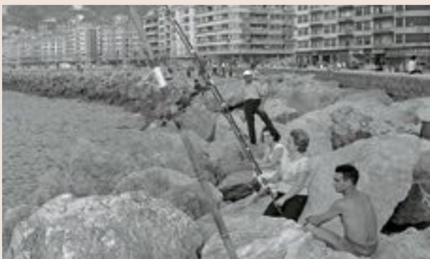
Figura 31. Escollera exterior de protección a la altura del Kursaal. https://www.kutxateka.eus
