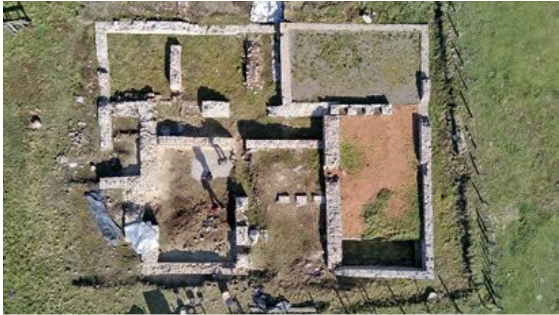
Trabajos de consolidación en el complejo termal de Zaldúa.
