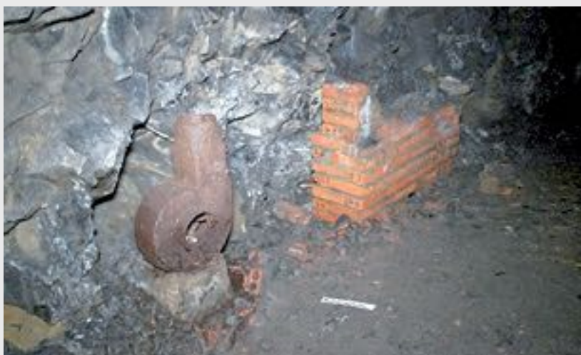
Restos del sistema de ventilación y renovación de aire del Túnel-refugio de Zabalbide (Bilbao).
