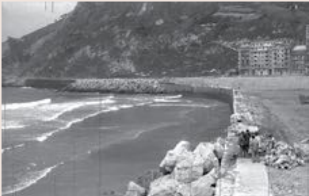
Figura 27. Primero se construyó de escollera de protección. https://www.kutxateka.eus
