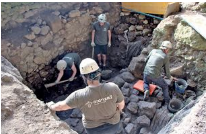
Proceso de trabajo en el emplazamiento del antiguo Ostatu en el Túnel de San Adrian/Lizarrate.
