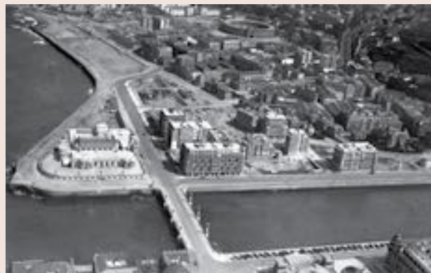
Figura 16. Muro de costa del ensanche del Kursaal sin terminar. https://www.kutxateka.eus
