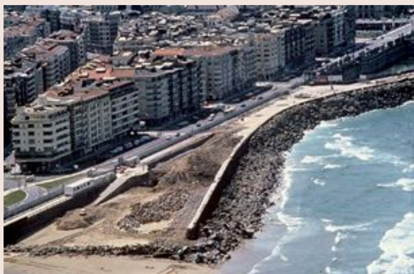
Figura 34. Proceso de desmantelamiento de la escollera. https://eltrajedelosdomingos.wordpress.com
