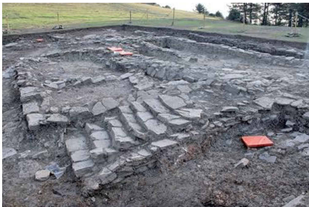
Escaleras de piedra excepcionalmente conservadas en una de las viviendas del Poblado vascón de Irulegi. © M. AIESTARAN
