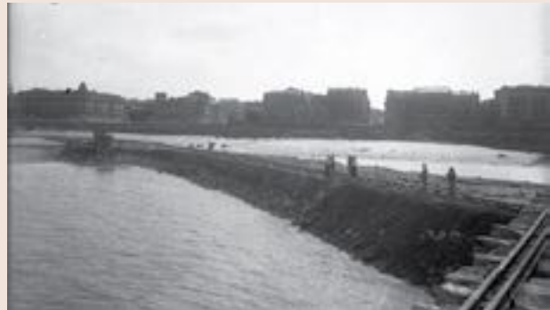
Figura 12. Construcción del muro del Kursaal. www.guregipuzkoa.eus
