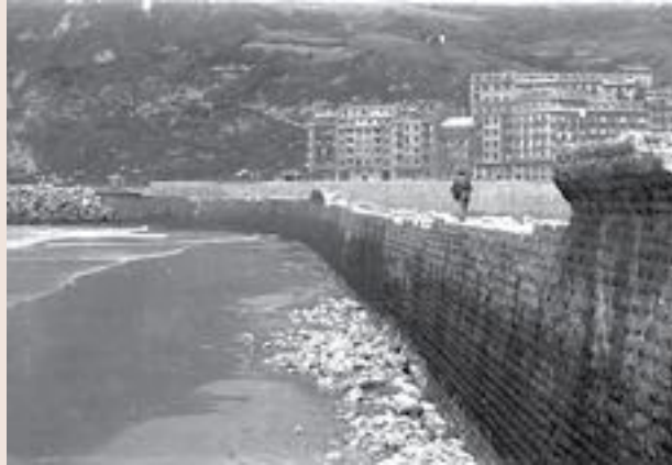
Figura 26. Inicio de la demolición del muro de costa oriental. https://www.kutxateka.eus
