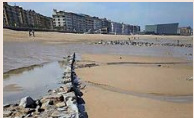
Figura 40. Cimentación del antiguo muro de costa. www.diariovasco.com
