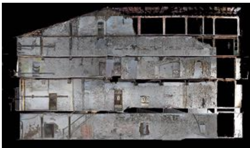
Alzado de las caras exterior e interior del muro de compartimentación (antigua fachada) del solar de Kale Nagusia nº 80 -Idiabez Ederra (Azkoitia). © E. ALONSO
