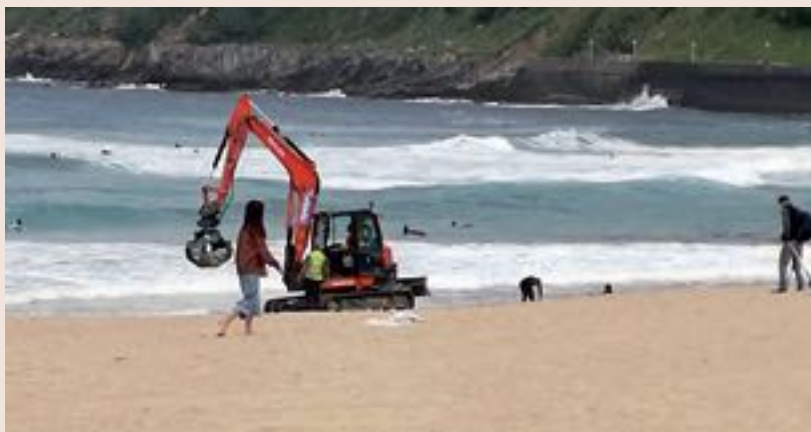
Figura 45. Detalle de la metodología de retirada de cascotes (18-05-2021).
