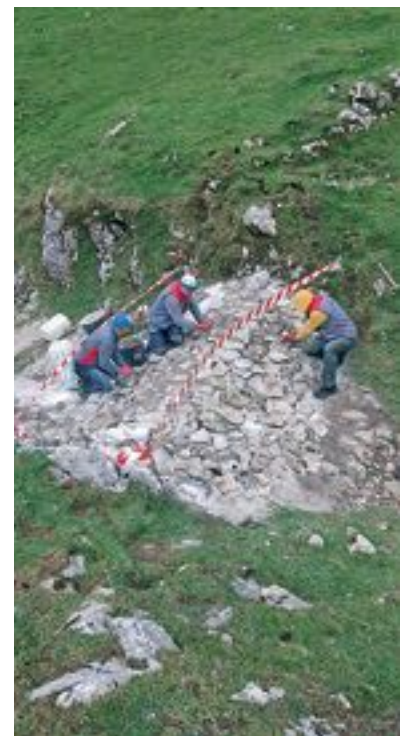
Proceso de ejecución del pequeño resalte en el Area II durante los trabajos de recuperación y consolidación en el Túnel de San Adrian/Lizarrate. A. MORAZA
