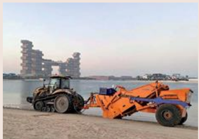
Figura 7. Despedregadora Triginer con el hotel Atlantis The Royal al fondo (03-05-2023).
