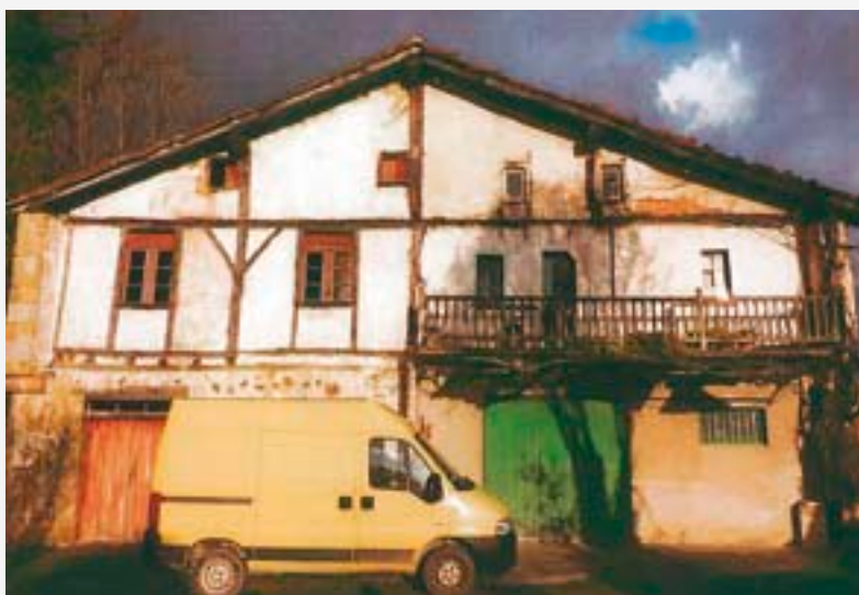
Fachada principal del caserío Tobar (Errenteria) en la que se aprecia el entramado enmascarado bajo el actual encalado. © J. Buces
