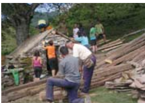
Colocando la nueva cubierta a la construcción auxiliar que se dedicaba al ahumado de los quesos.
