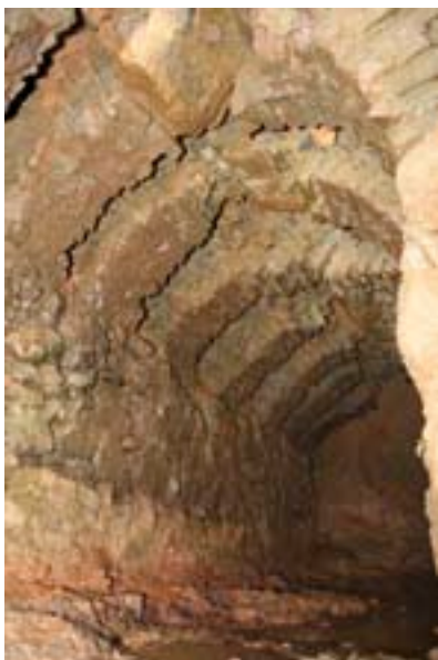
Detalle de la arcada de la cámara de combustión de la tejera de Telleria (Meñaka). © A. Moraza
