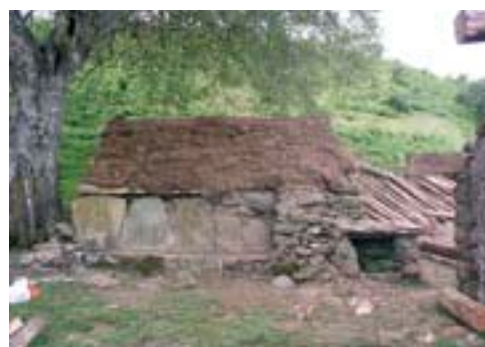
La construcción auxiliar con la cubierta vegetal o tepes “zotalak” colocados sobre la placa de “onduline”.
