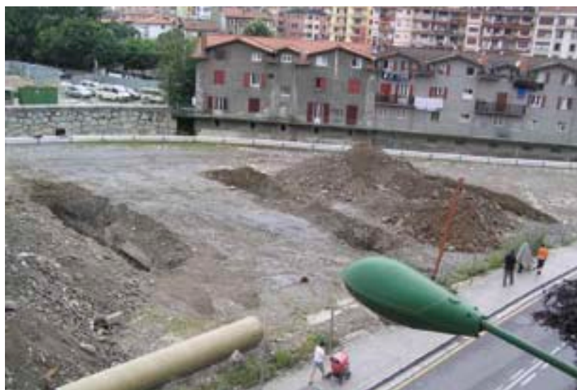
Vista general del emplazamiento del solar de las derribadas instalaciones de la papelera "La Tolosana", con la ubicación de los distintos sondeos arqueológicos. 📷 M. García
