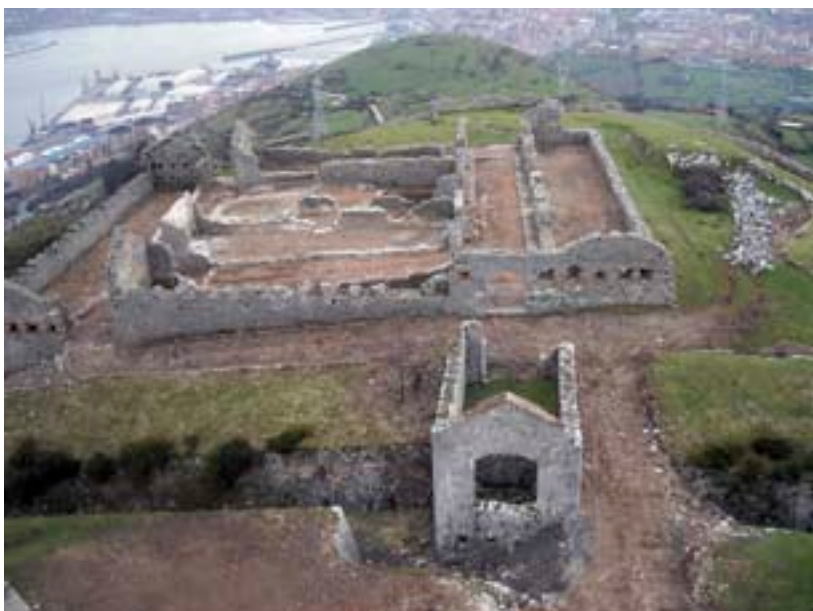
Estado actual de las instalaciones militares de Fuerte Serantes tras las labores de limpieza y documentación arqueológica. Aerodik-Aranzadi
