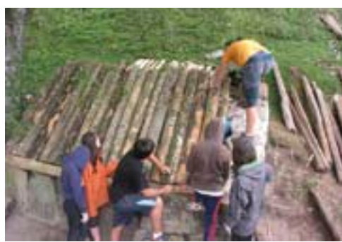
Colocación de los cabrios en la txabola.
