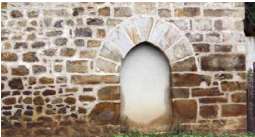
Arco apuntado de acceso original a la Torre de Zumeltzegi (Oñati) por su fachada Sur actualmente cegado.
