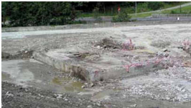
Detalle de los cimientos de la antigua central eléctrica tras el derribo del resto de las instalaciones. © A. Moraza
