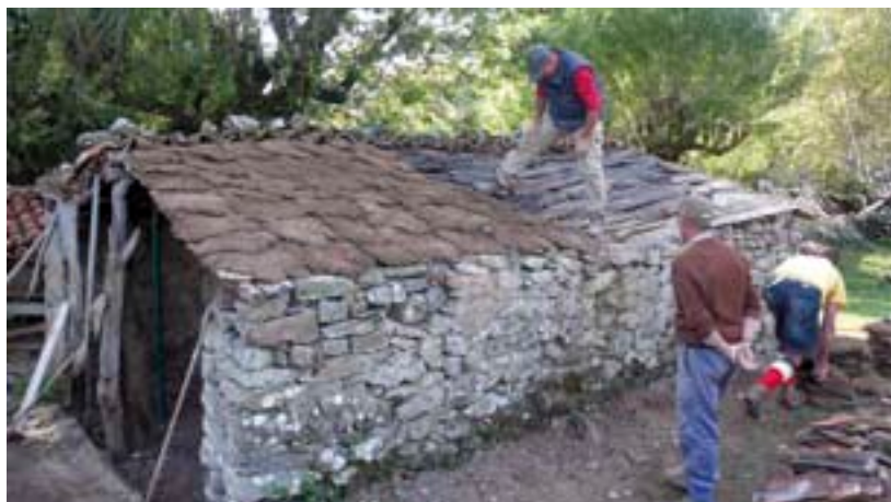
Colocación de fotala (tepes) sobre la cubierta. © M. Otaño
