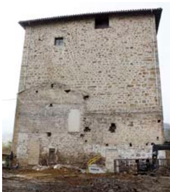
Fachada Norte de la Torre de Zumeltzegi (Oñati) tras el derribo de las distintas edificaciones anexas M. Garcia
