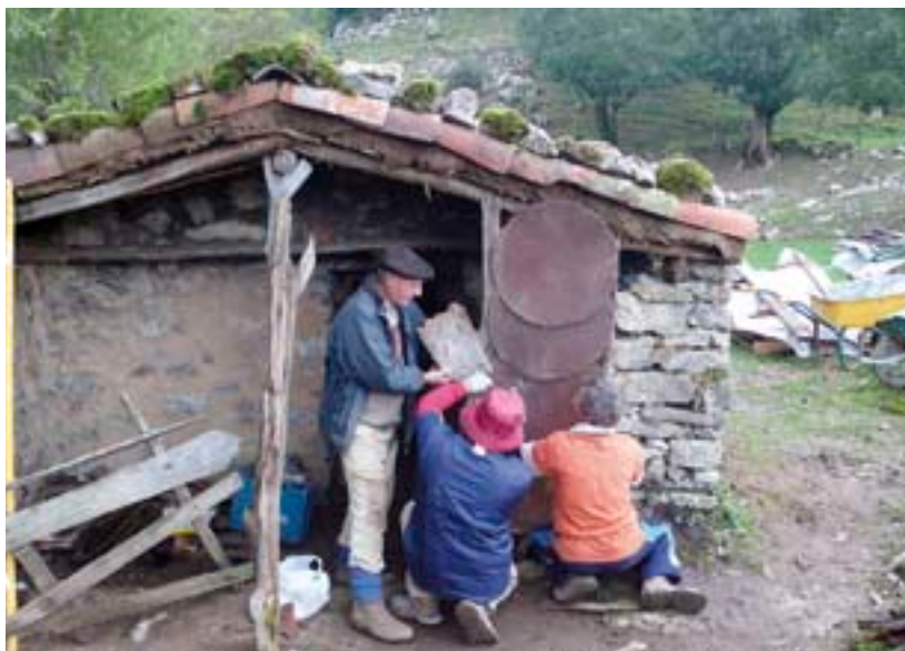
Arreglando la fachada principal de la chabola Gorriñe. © M. Otaño
