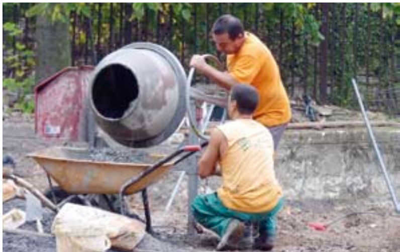
Trabajadores de la especialidad de albañilería.
