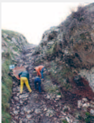
Proceso de eliminación del escombro en la boca de acceso Oeste al Túnel de San Adrian.
