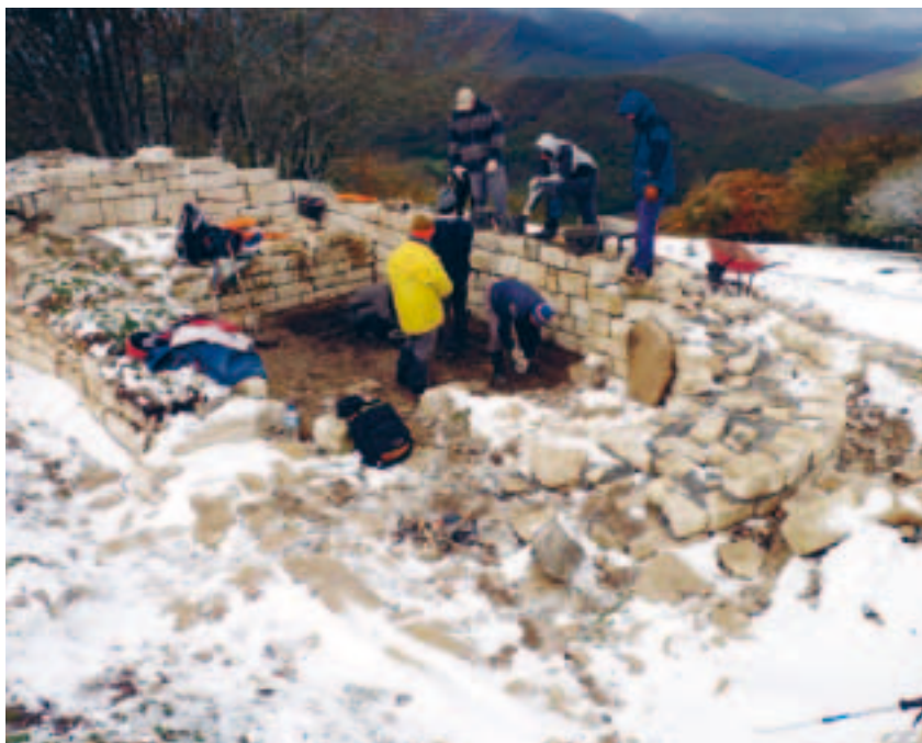
Desarrollo de los trabajos de consolidación de los restos de la ermita de San Gregorio de Larunbe.
