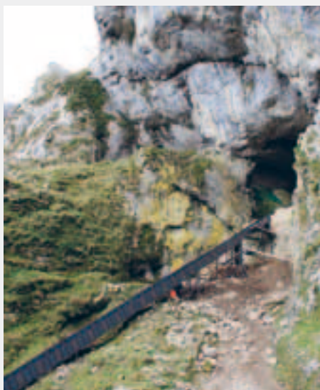
Proceso de construcción de la rampa ejecutada para evacuar los escombros del interior del túnel de San Adrian.
