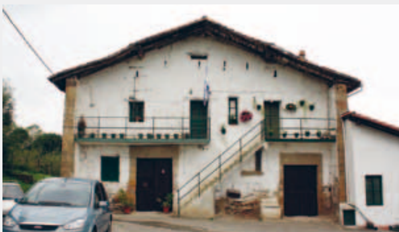
Fachada principal del caserío Bentaundi, situado al pie del Fuerte de Oriamendi. En su fachada se aprecian las aspilleras para fusilería A. MORAZA
