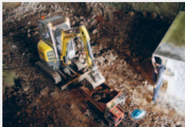
Desarrollo de los trabajos de limpieza por medios mecánicos en el interior del Túnel de San Adrian. 📷 A. MORAZA
