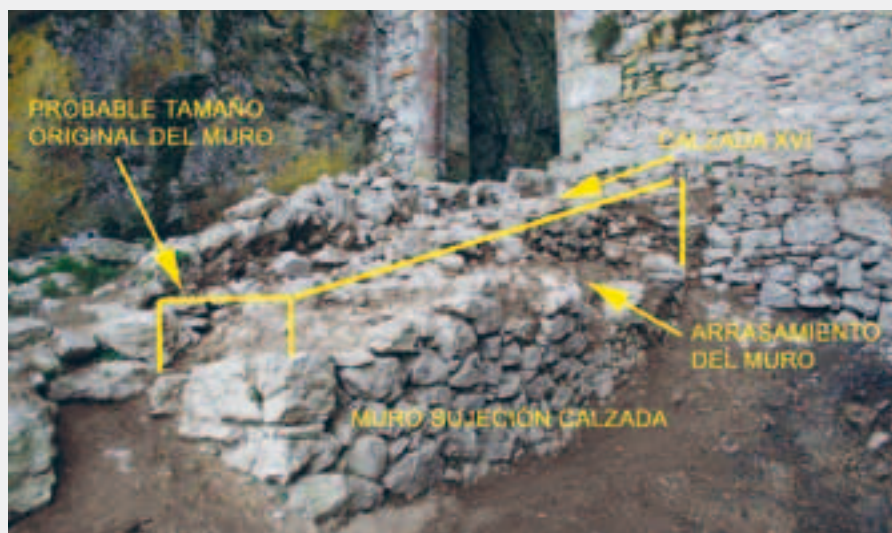
Detalle desde la parte inferior de las estructuras constructivas relacionadas con la calzada de época Moderna destinadas a salvar el desnivel para acceder al Túnel de San Adrian. ✉ M. CEBERIO
