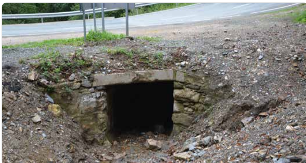
Fig. 80. Tajea de la carretera construida en 1881 con reciclado de sillares.
