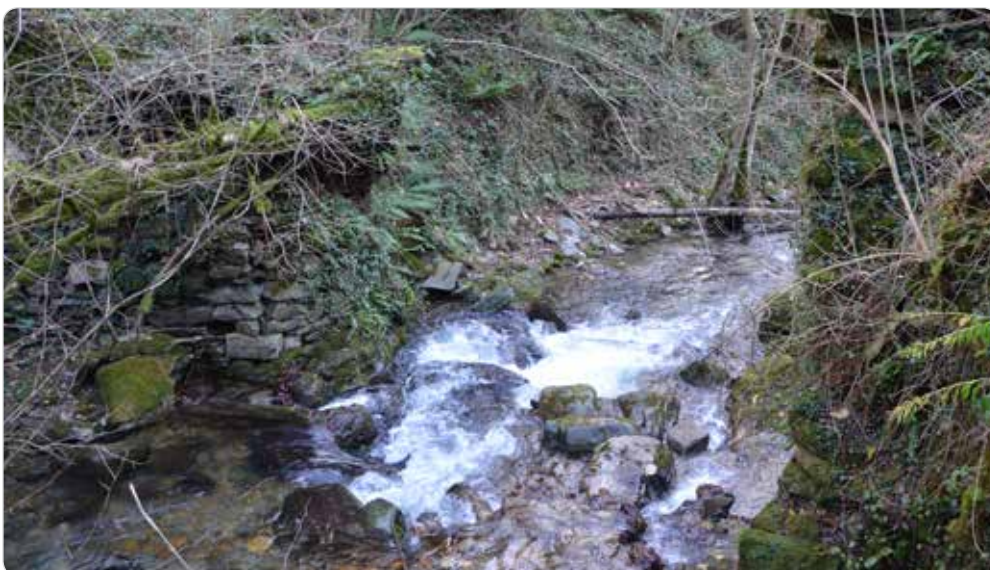
Fig. 117. Estribos del puente en Xokotoko erreka.
