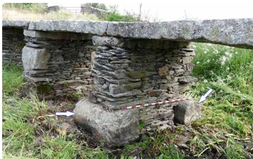
Fig. 19. Quinto pilar del puente, en el que se observan los dos fragmentos reutilizados en su construcción, aguas arriba y abajo, que conformaban el miliario 1. Fotografía tomada inmediatamente antes de procederse al desmonte del pilar.
