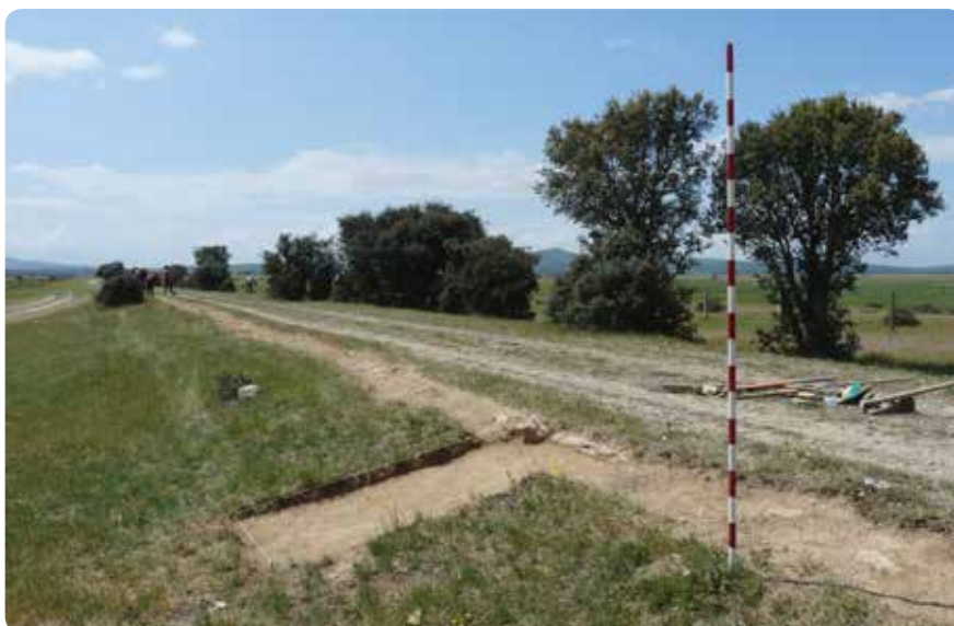
Fig.7. Uno de los múltiples sondeos efectuados para delimitación de los bordillos de la calzada, avanzada la milla 154. Nótese el alto terraplén sobre el que discurre la misma. La finalidad de estos sondeos fue adivinar la alineación de la vía descubriendo los bordillos de delimitación allí donde no eran visibles.
