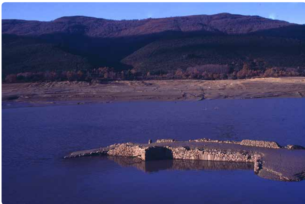
Fig. 11.- El puente Ranero aguas arriba, sobre el río Ordunte en diciembre de 1986, frente a la cuesta de Tamadero, en Partearroyo, que permanece sumergido casi permanentemente en las aguas del embalse de Ordunte, en el trayecto del camino de las Enderrozas y que la documentación del AHVM cita en 1593 como construido en madera.
