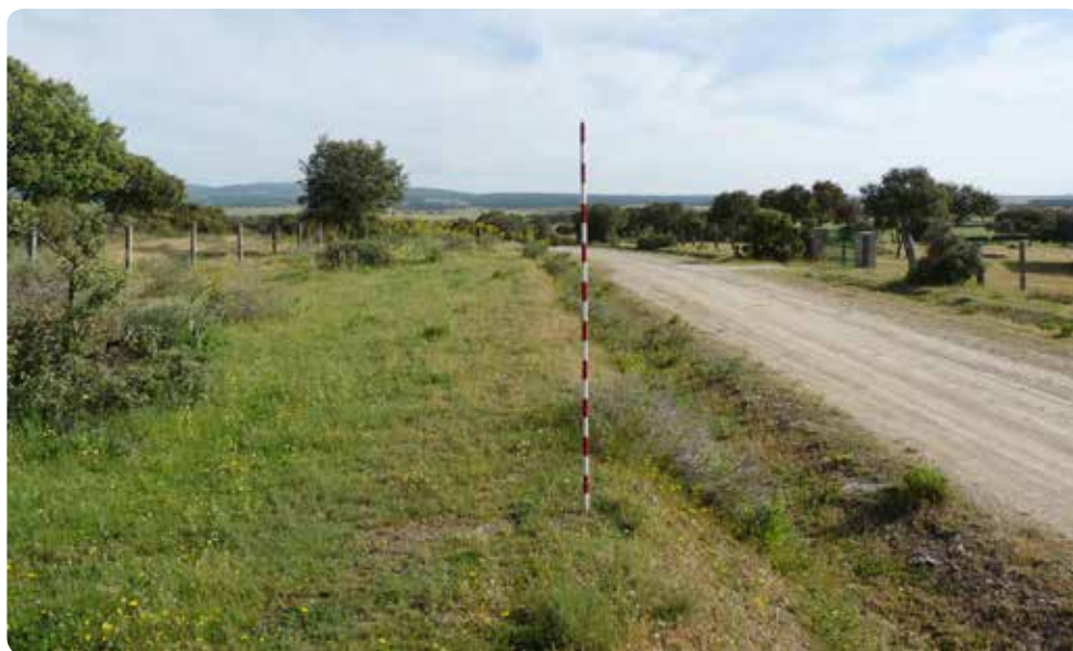
Fig. 5. Vista de la calzada en su avance hacia el norte, a la altura de la milla 152, en el inicio del tramo donde se ha intervenido.
