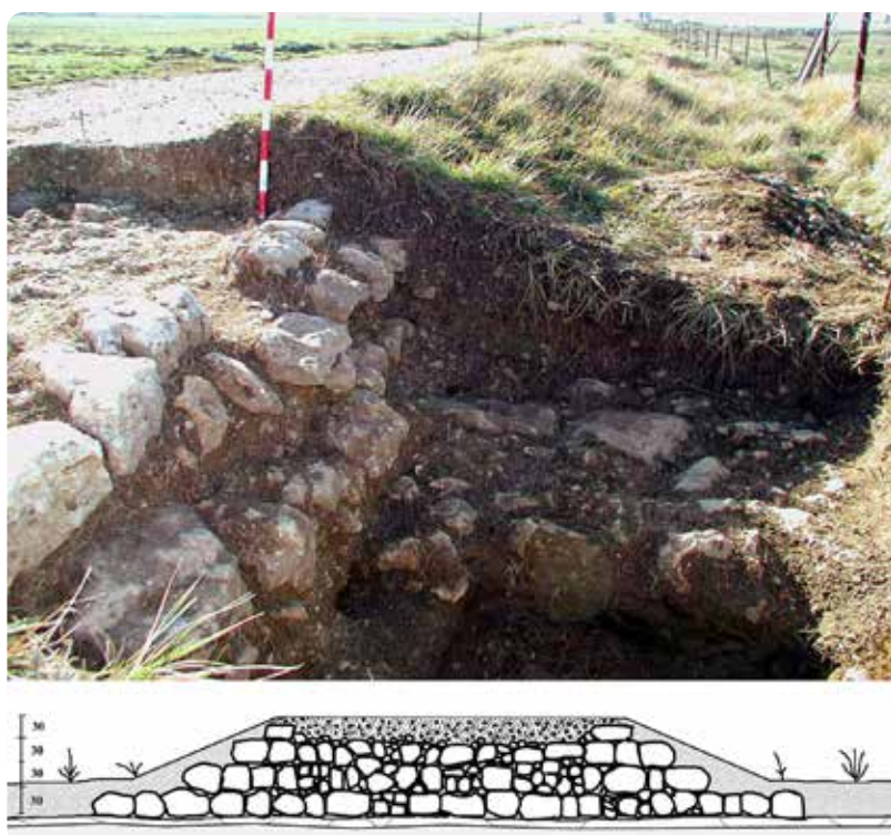
Fig. 17. Estructura del afirmado de la vía de Italia a Hispania en Hurones (Burgos). www.viasromanas.net
