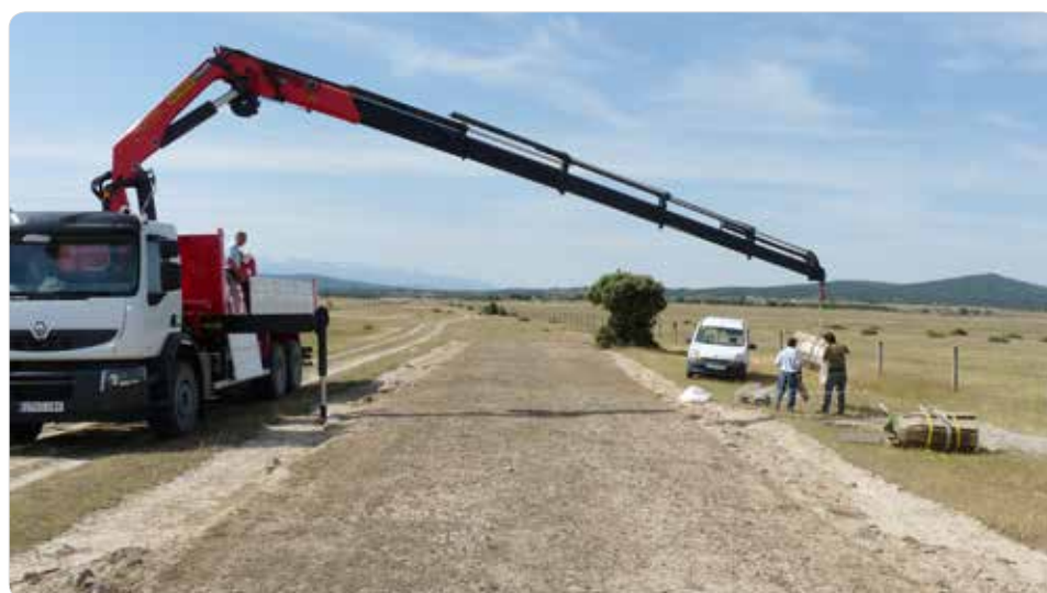
Fig. 25. Un momento del proceso de traslado, descarga e instalación del miliario 2 del puente en la milla 154 de la Vía de la Plata. Fue necesaria la utilización una larga grúa telescópica para evitar rodar sobre el firme de la calzada.
