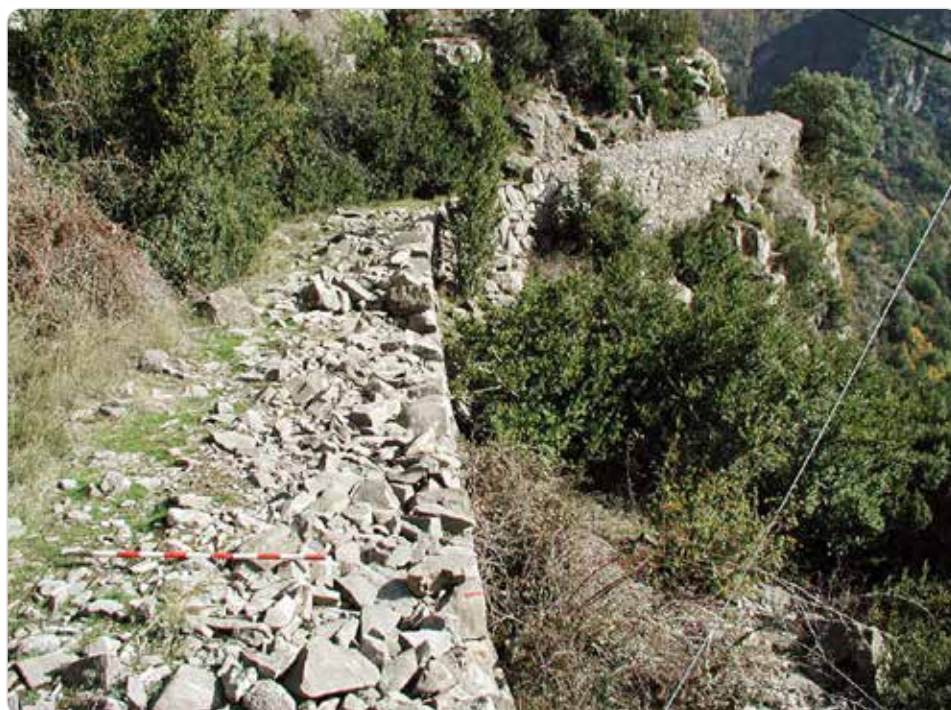
Fig. 25. Aspecto del camino del Puerto del Palo en el único sitio que presenta alguna estructura constructiva de interés. Se trata de un muro de contención de mala factura, para sostener un camino de dos metros de ancho. Cuellos de Lenito en el Valle de Echo.
