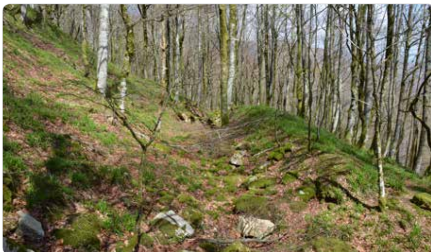
Fig. 81. Descenso con derrubios del ensanchamiento de carretera.
