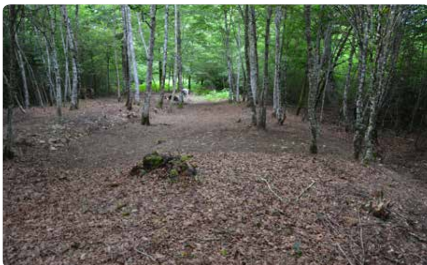
Fig. 64. El afirmado de la calzada cortado longitudinalmente por el paso de los carruajes.
