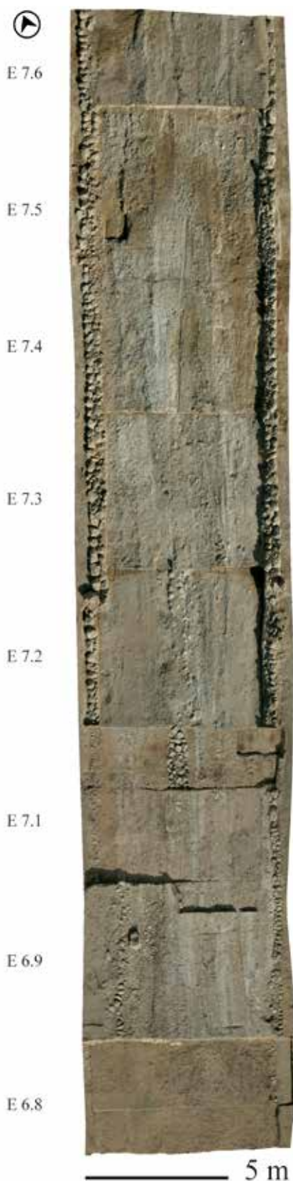
Fig. 23. Ortofoto general del tramo norte excavado por escalones.
