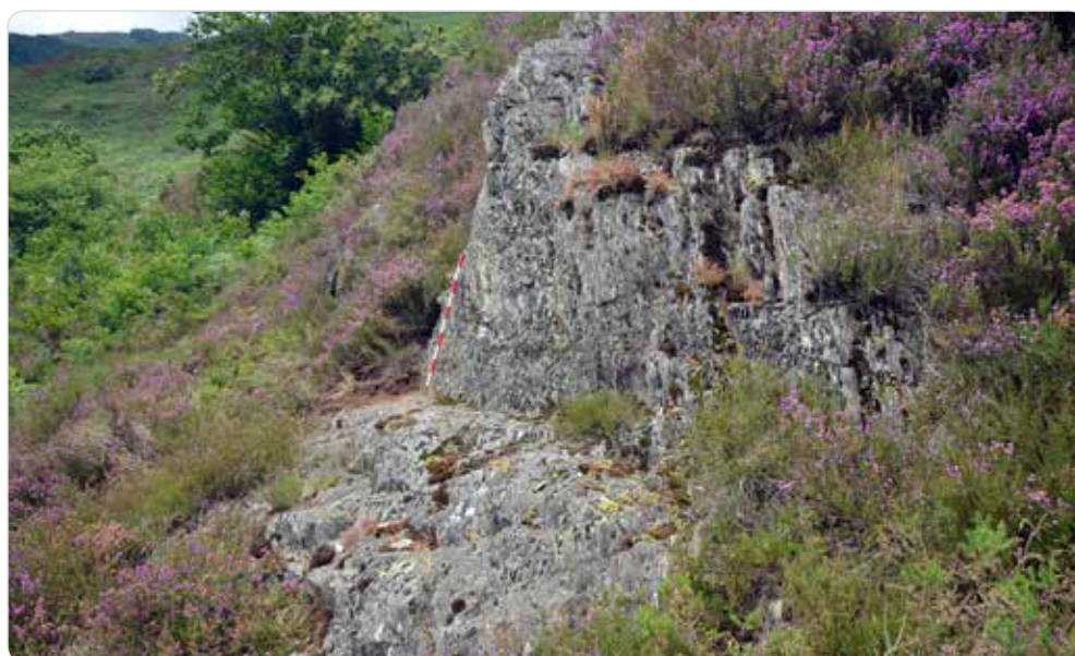
Fig. 29. Uno de los muchos entales, realizados a golpe de pico, para el paso de la vía romana en Valcarlos.
