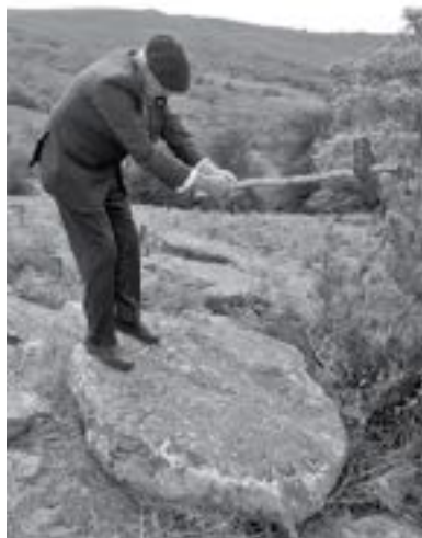
Figura 25. Simulación de un cantero (Javier Álava) trabajando con la almádena, en la cara sur de Gorbeia (2016).
