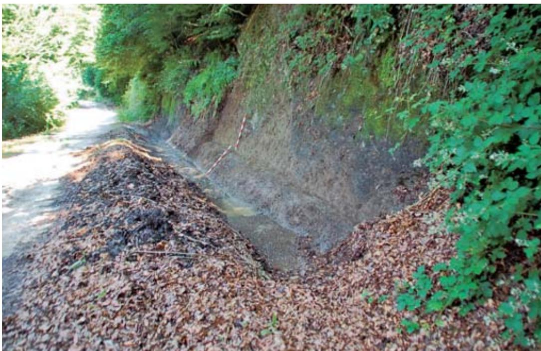
**Fig. 108.** Desmante acabado a pico con escalón. *Txoperena*.
