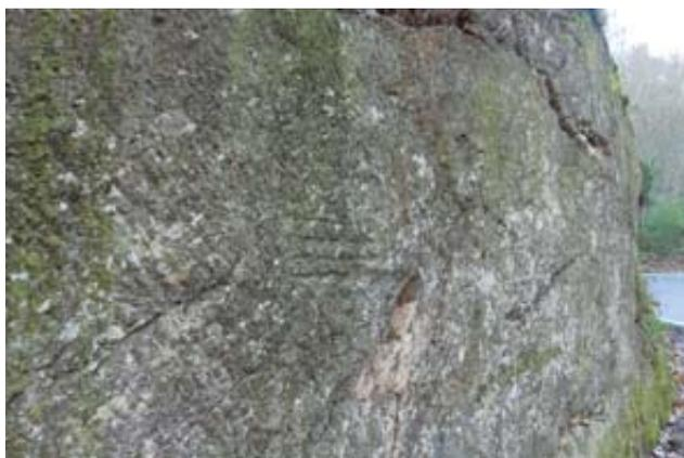
**Fig. 82.** Detalle del acabado a pico en taludes verticales. *Txoperena*.
