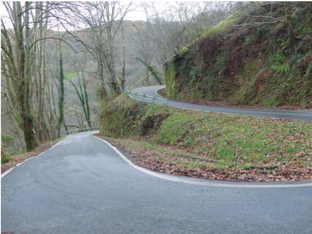
**Fig. 85.** Desmontes entallados a pico e inclinación de ladera. *Txoperena*.
