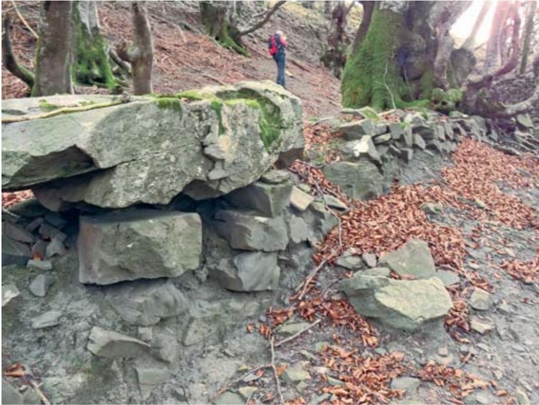
**Fig. 48.** Muro de contención de la plataforma. *Txoperena*.
