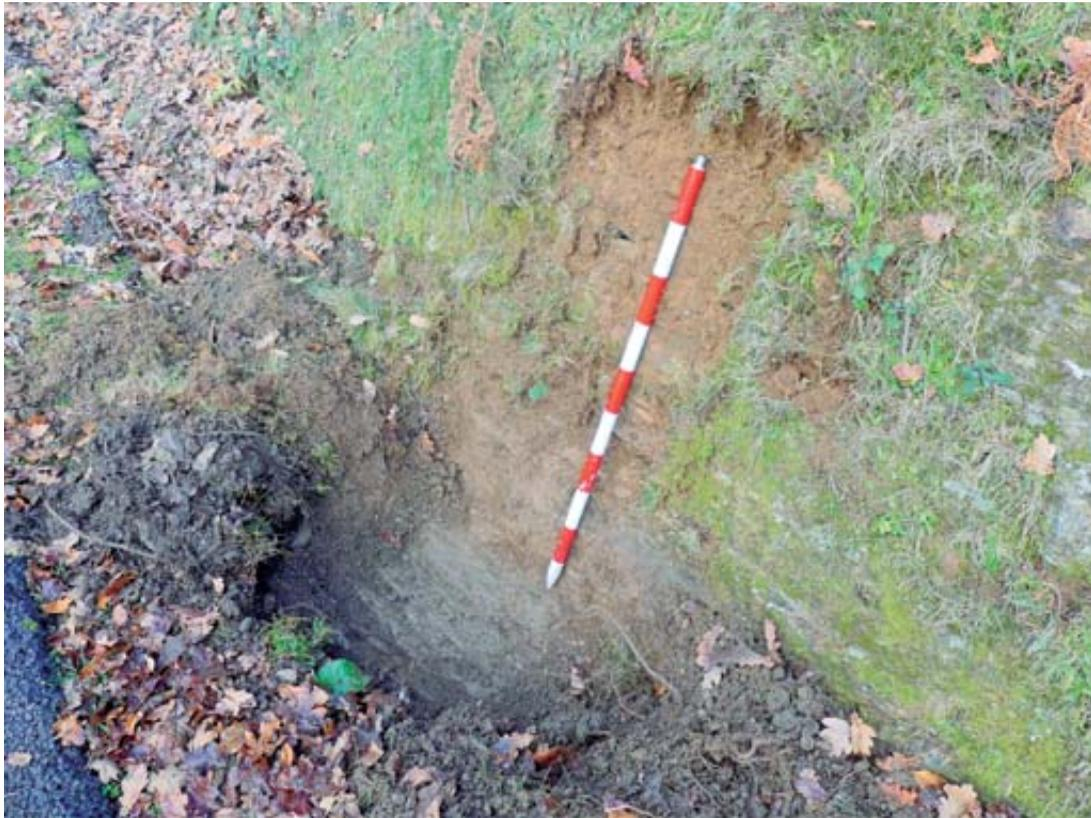
**Fig. 86.** Talud cortado a pico y cuneta en la bajada hacia Sara. *Zubiria*.
