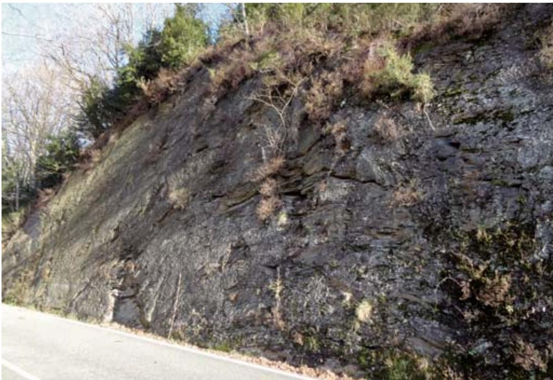
**Fig. 56.** Escarpe tendido acabado a pico. *Txoperena*.
