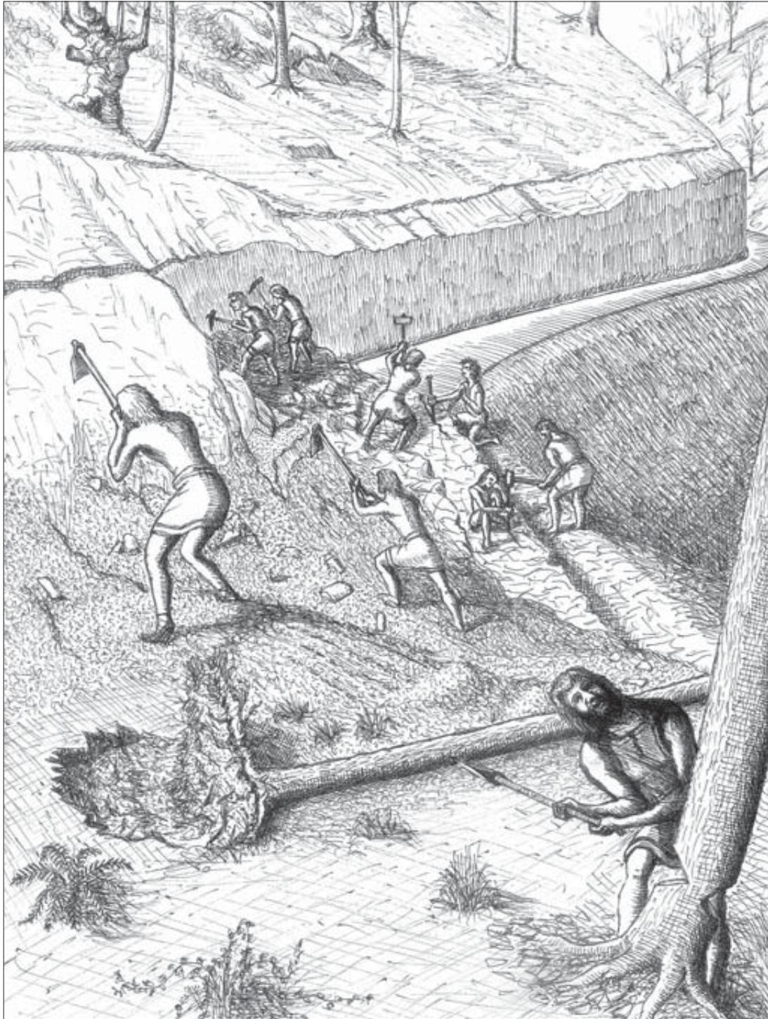
**Fig. 83.** Recreación de los trabajos de deforestación y desmonte para la apertura del camino. *Txoperena*.
