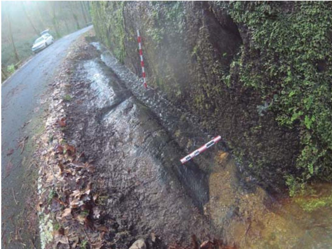
**Fig. 80.** Desmontes verticales y cunetas talladas en la roca. Se aprecia el desgaste de las llantas de hierro sobre los esquistos. *Zubiria*.
