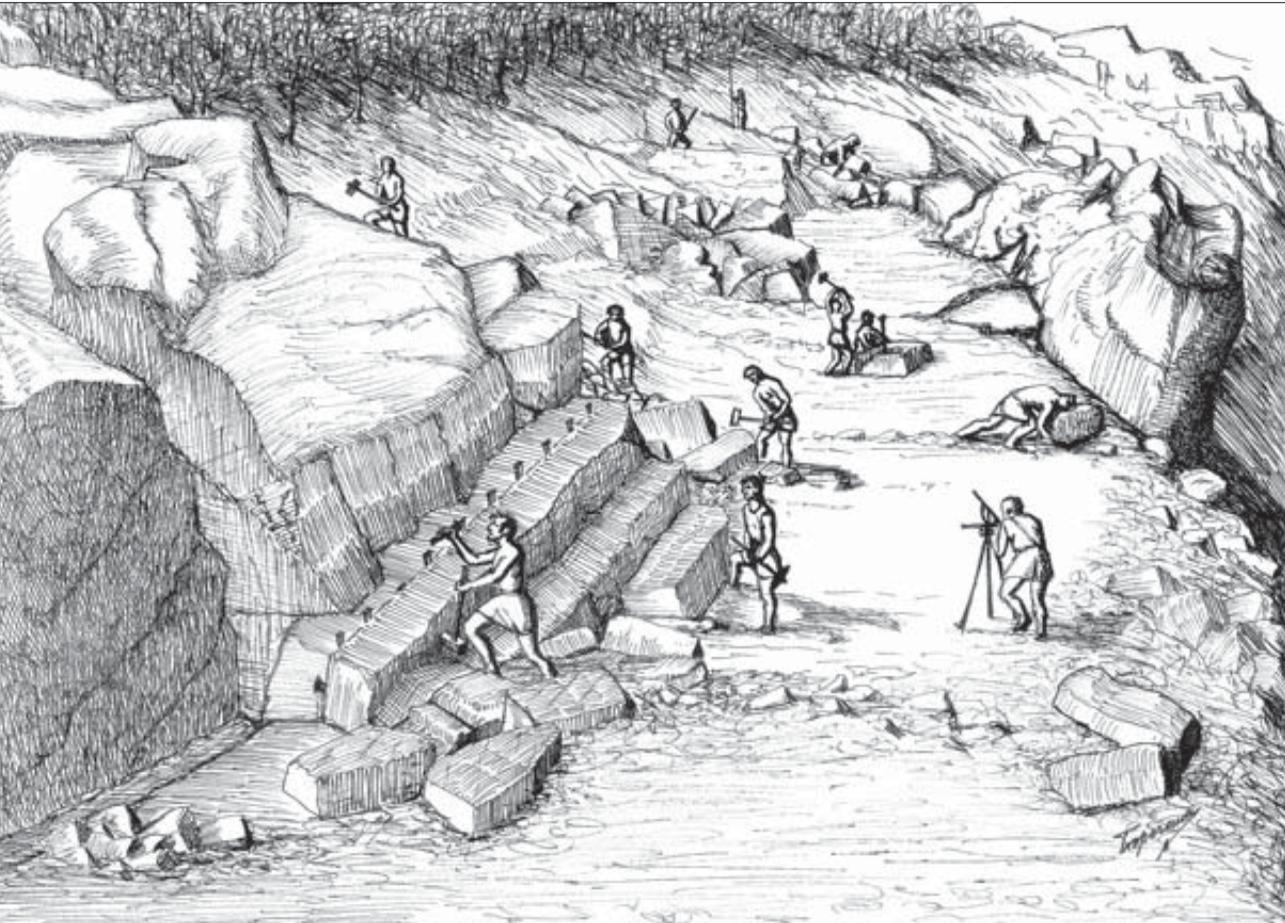
Fig. 87. Recreación de los trabajos de desmonte para la construcción de una calzada en ladera. *Txoperena*.
