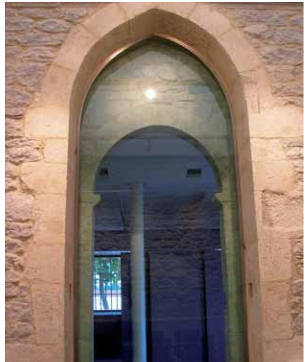
Fig 8. Acceso de la segunda fase de la ermita de San Martín compuesto por el vano reutilizado (ue 23) en el exterior y el nuevo arco ojival (ue 22) en el interior.
