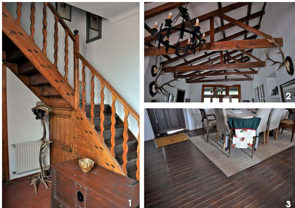
Fig. 11. Varios elementos de madera en el interior de Villa Alicia, posiblemente originales ingleses. 1: Escalera de acceso a la planta superior del cuerpo central. 2: Armadura de la cubierta del ala S. 3: Parqué del salón principal de la casa (cuerpo central). Fotos: autor.
