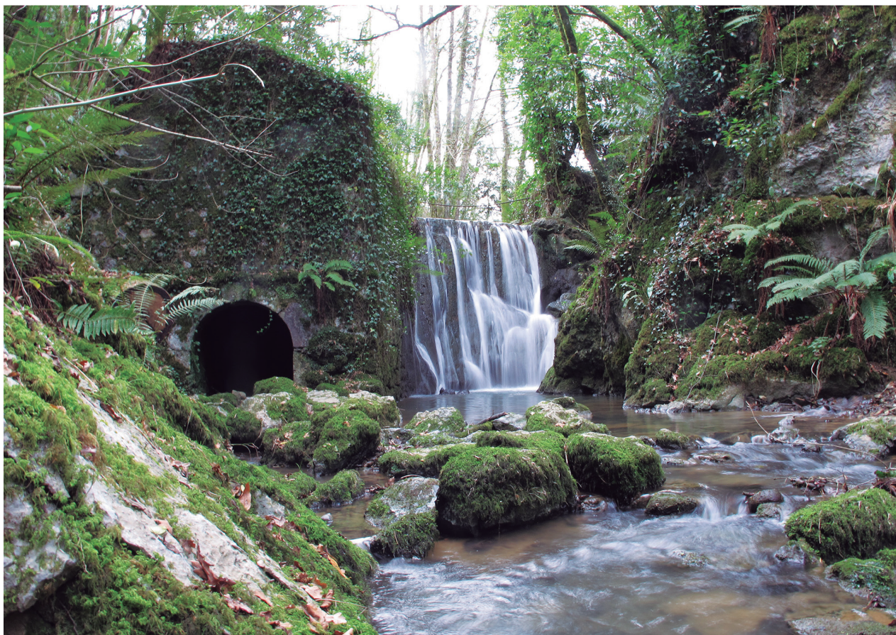
Fig.8. Azpiegitura hidraulikoak Oma haranean. (Goian) Olakoerrota burdinola. (Behean) Bolinzulo errota. Iturria: Eusko Jaurilaritza, Kultur Ondarearen Zentroa / Hydraulic infrastructure in the Oma valley. (Above) Olakoerrota forgergy. (Below) Bolinzulo mill. Source: Basque Centre for Cultural Heritage.
