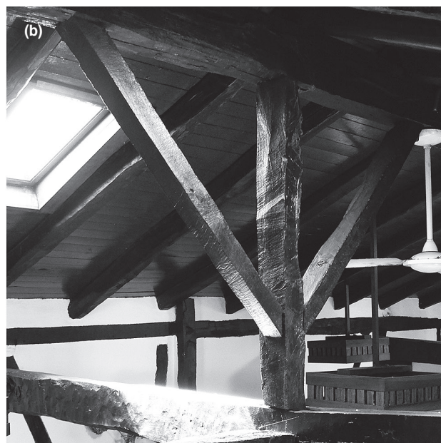
Fig.12. Detalles de las uniones de madera. (a) unión entre pilares centrales, frontales y cumbrera; al fondo, vista interior del encuentro a triple espiga entre los montantes de las fachadas laterales y los frontales. (b) pilar y tornapuntas de apoyo de la viga cumbrera. / Details of the timber connections: (a) connection between central, front and ridge pillars; in the background, view of the triple herringbone connection between the uprights of the side and front facades. (b) pillar and support braces of the ridge beam.
