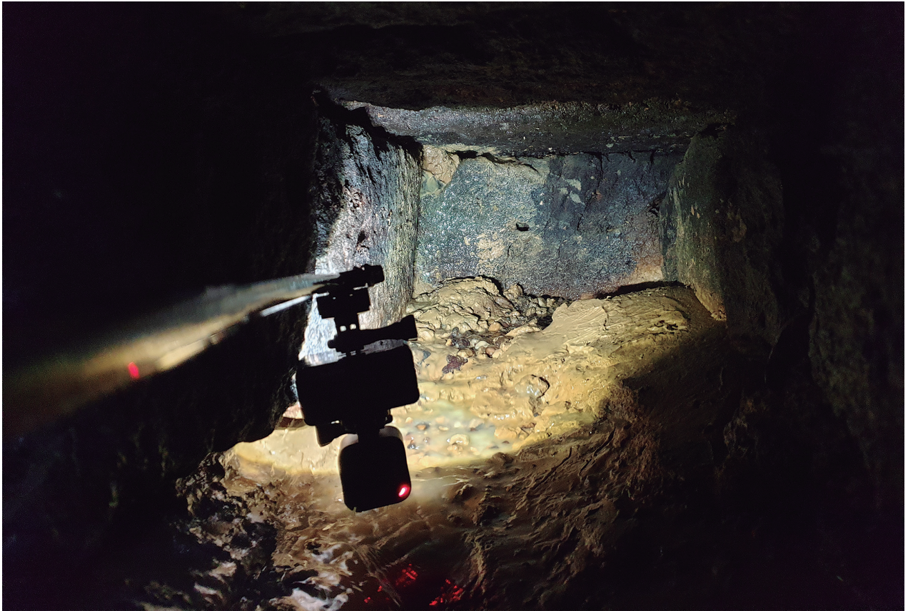
Fig.6. Imagen del interior del canal, al fondo se observa una coloración rojiza producto de las aguas ferruginosas. En la parte baja cuenta con cierta colmatación sedimentaria / Image of the interior of the channel, in the background there is a reddish coloration product of ferruginous waters. In the lower part it has some sedimentary silting
