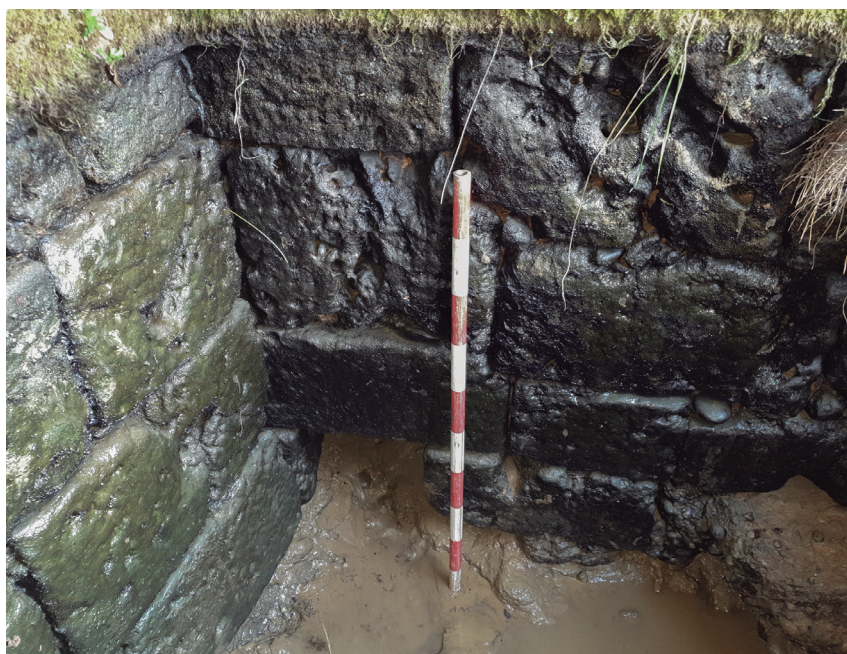
Fig. 5. Vista del interior del depósito después su drenaje. En primer plano se encuentra la entrada del canal de abastecimiento / View of the interior of the tank after its drainage. In the foreground is the entrance to the supply channel.
