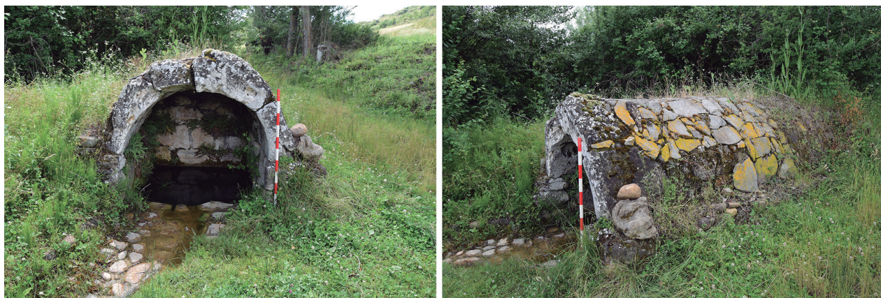
Fig.3. Fuente de Valdealcón, a la izquierda una imagen frontal, a la derecha una vista lateral / Fountain of Valdealcón, on the left a frontal image, on the right a side view.
