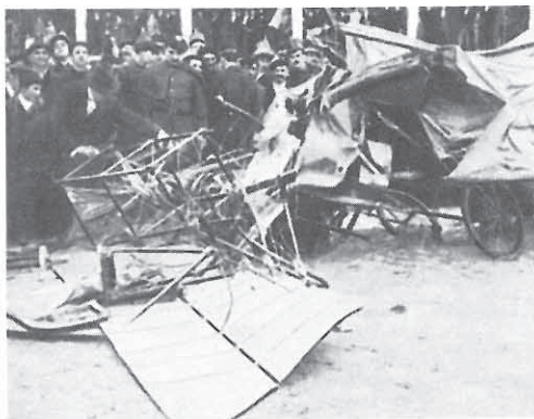
Estado en que quedó el aparato después de la caída.
