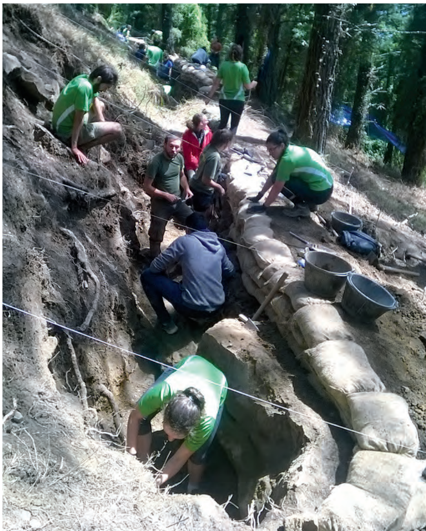
Ipar-ekialdeko sektoreko (NE) lubaki-zati baten indusketa. Excavación de un tramo de trinchera del Sector noreste (NE) (Tito Agirre, 2017).
