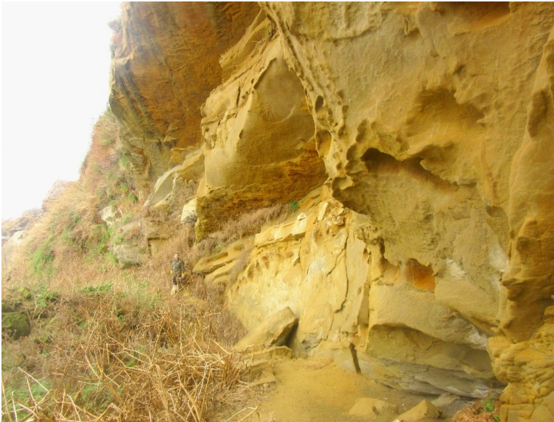
Figura 21. Extensas cornisas con multiplicidad de geoformas sobre las paredes arenizadas. Con restos de gangas de cannonballs. Las intercalaciones de lutitas se presentan finamente fracturadas.
