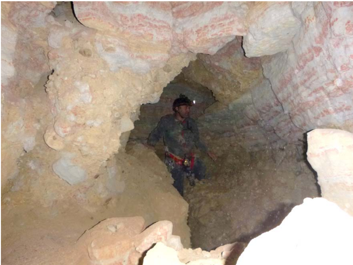
Figura 17. Cauce inferior con arcilla húmeda y crecimientos de cristales aciculares de yeso (arriba). Detalle de colapso de estratos granulares de lutitas rojas y ocre, muy disgregables (debajo). Sima del Risco 02.
